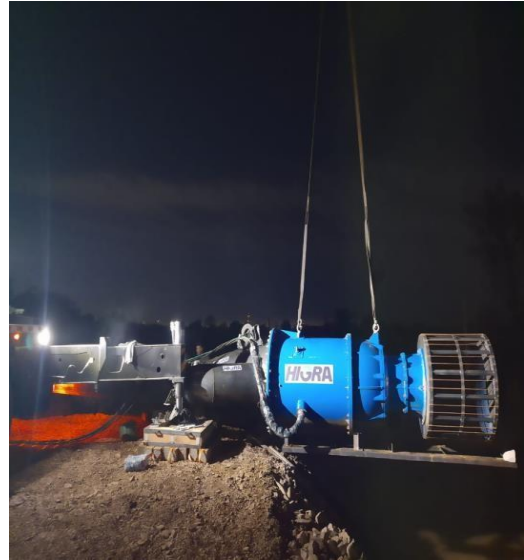
lçamento em Ponte Rolante móvel adaptada em guindaste para movimentação de carga, massa do conjunto motobomba aprox. 5,5 toneladas
