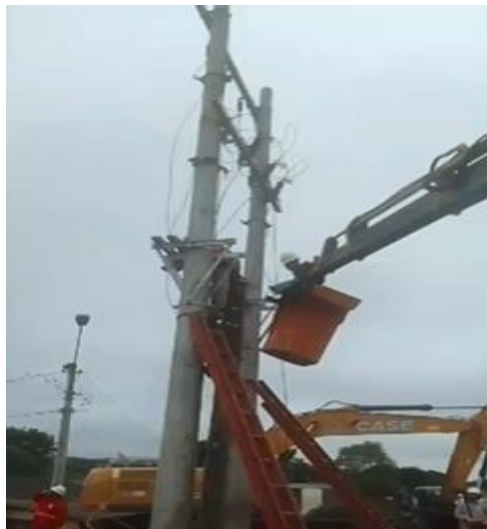
Execução de subestação para alimentação dos painéis elétricos
