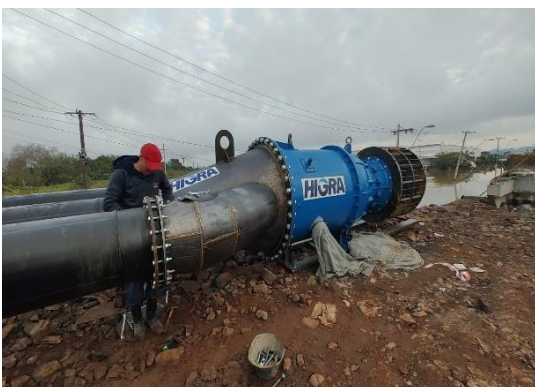
Montagem do sistema em campo
