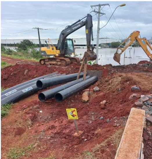
Preparação do terreno e execução da casa de bombas provisória para drenagem emergencial
