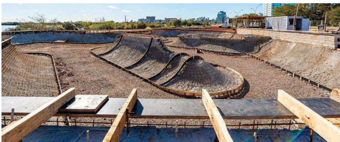
Figura 12 - foto ilustrativa das formas de madeira
