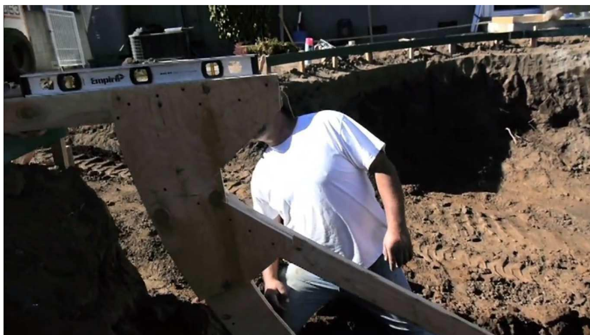
Figura 3 - foto ilustrativa da escavação
