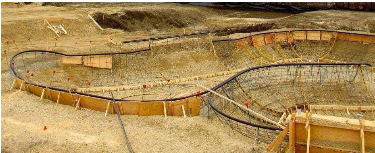
Figura 5 - foto ilustrativa das ferragens
