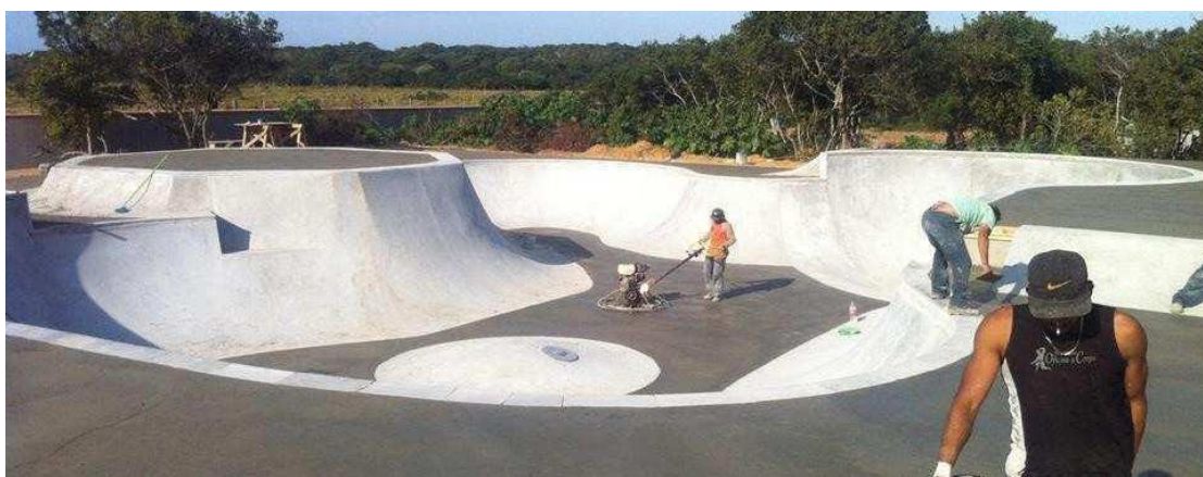
Figura 23 - foto ilustrativa concretagem dos pisos planos
