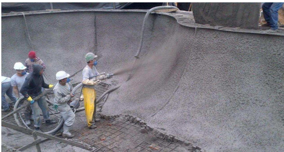
Figura 10 - foto ilustrativa da projeção do concreto magro
