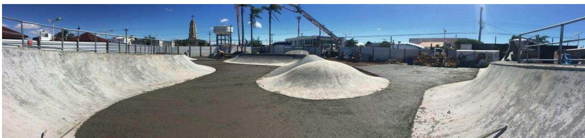
Figura 21 - foto ilustrativa concretagem de pisos planos
