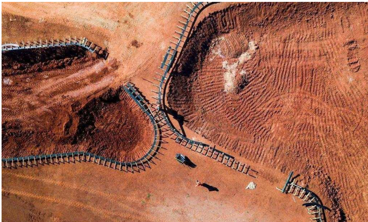
Figura 2 - foto ilustrativa da escavação
