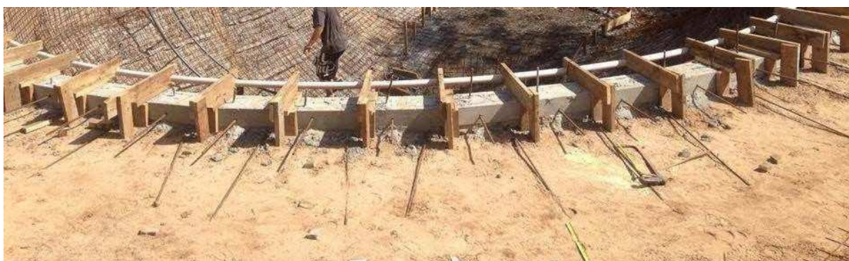
Figura 15 - foto ilustrativa das barras de transferência
