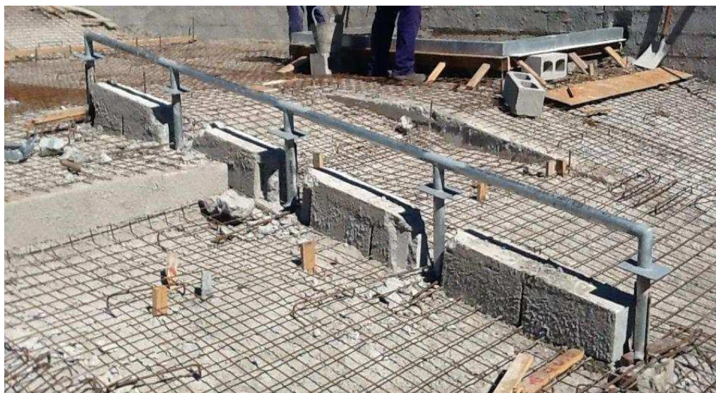
Figura 8 - foto ilustrativa da fixação do corrimão
