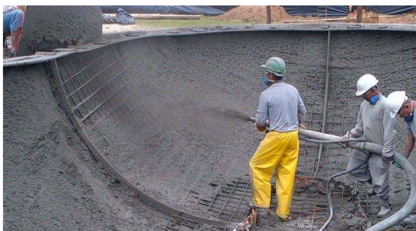
Figura 16 - foto ilustrativa da projeção do concreto
