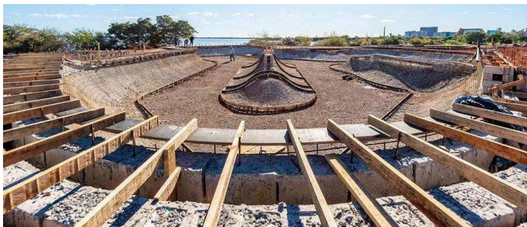
Figura 11 - foto ilustrativa das formas de madeira
