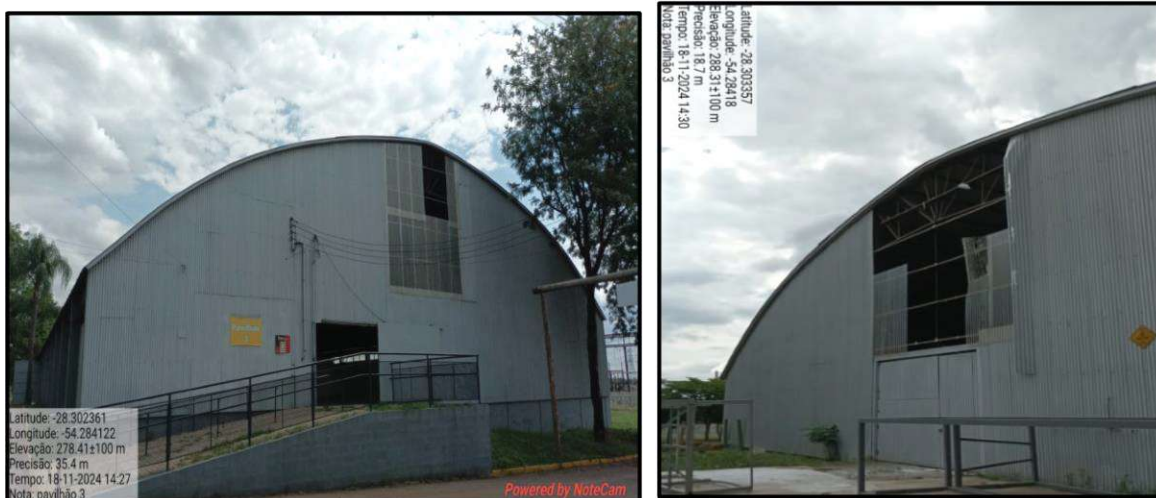
Imagem 12: Situação em que se encontra o Pavilhão 3
