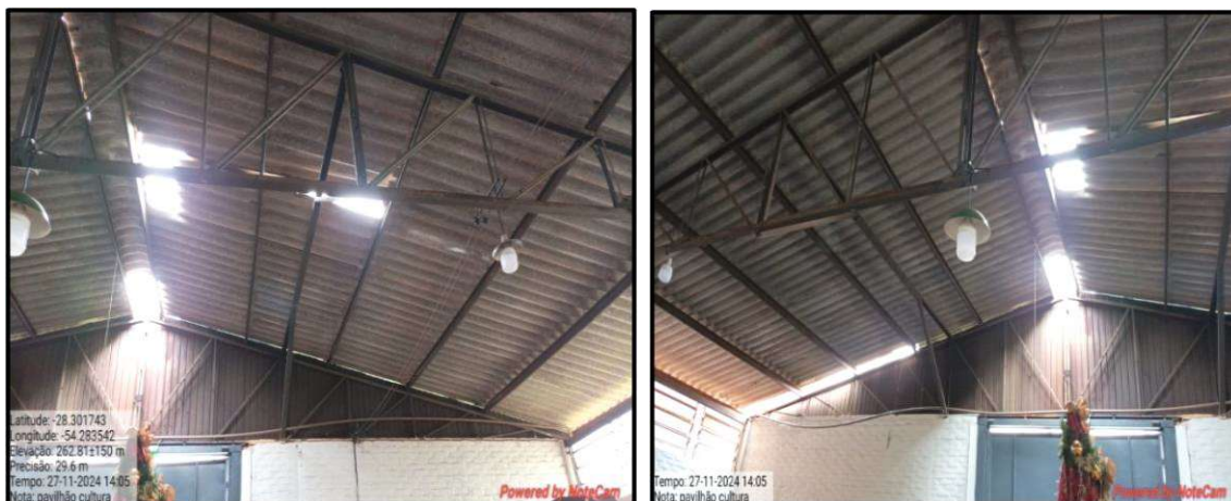
Imagem 11: Situação atual do Pavilhão Cultural.
