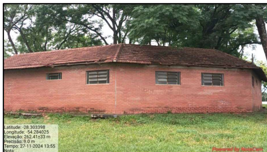
Imagem 9: Vista geral do banheiro.
