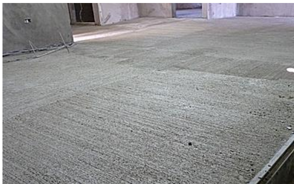
Figura 2: Passeio com acabamento vassourado
