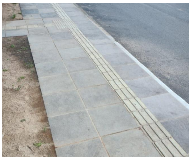
Figura 3: Piso em pedra (basalto)
