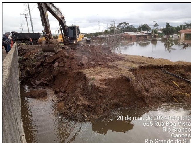
Figura 12: fechamento provisório dique Rio Branco
