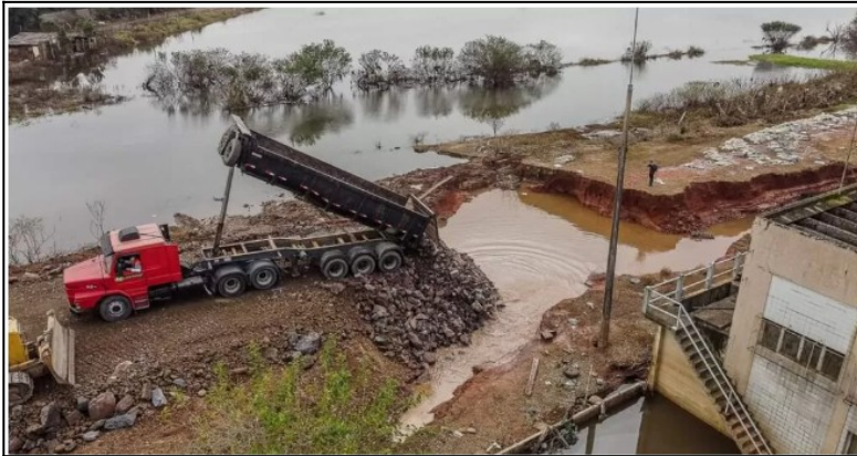
Figura 13: fechamento provisório dique Mathias Velho
