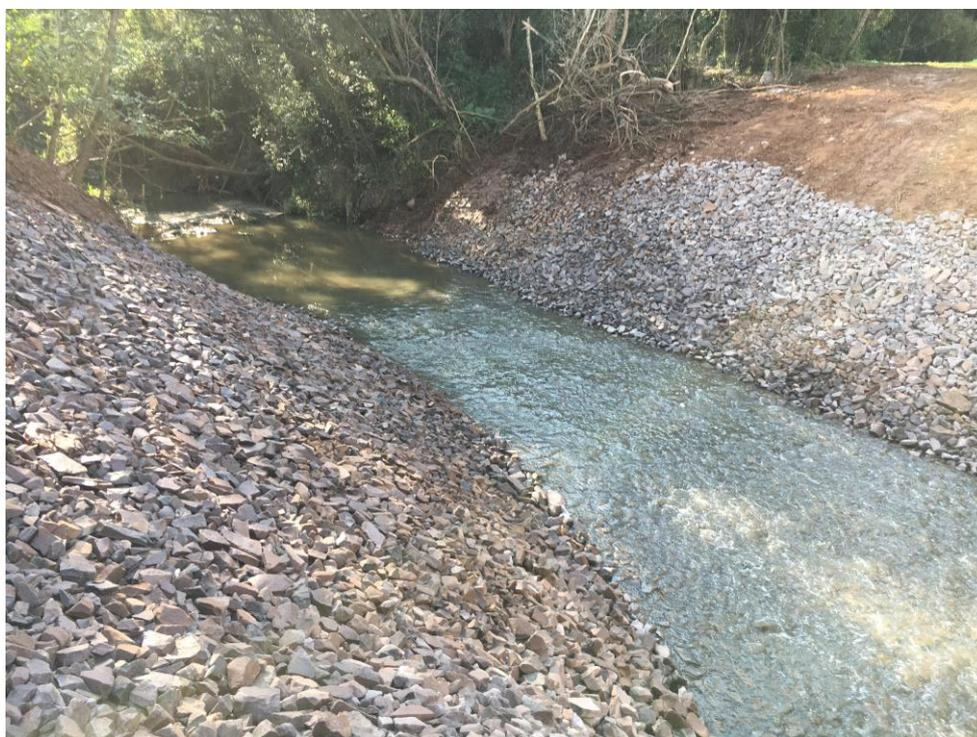
Imagem ilustrativa – Camada de rachão nas encostas dos taludes
