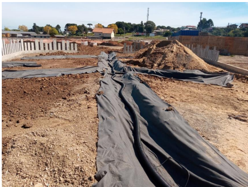
Exemplo do sistema de drenagem
