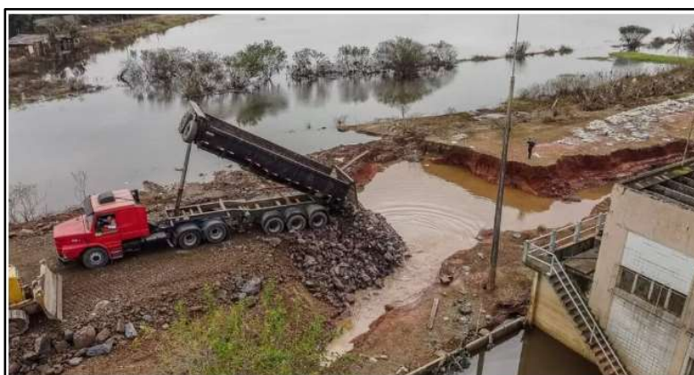
Figura 13: fechamento provisório dique Mathias Velho
