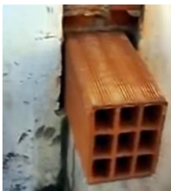
Amarração entre alvenaria nova e existente
