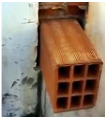
Amarração entre alvenaria nova e existente
