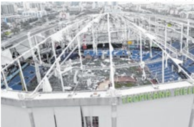
Estádio em Tampa que servia de abrigo ficou destruído
