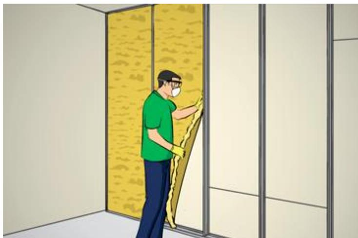
Ilustração: instalação do isolamento acústico – Leroy Merlin
