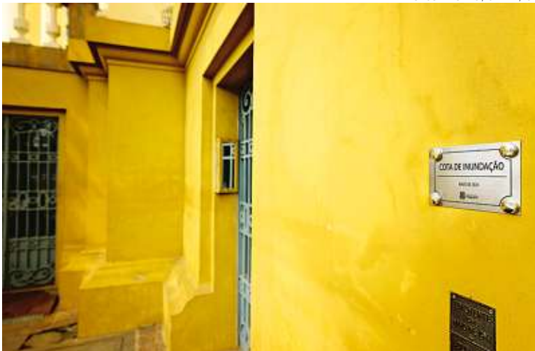
Placa foi colocada em cima da que remete à enchente de 1941
