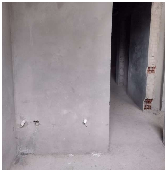
Imagem 10 e 11 – hidráulica do sanitário masculino
