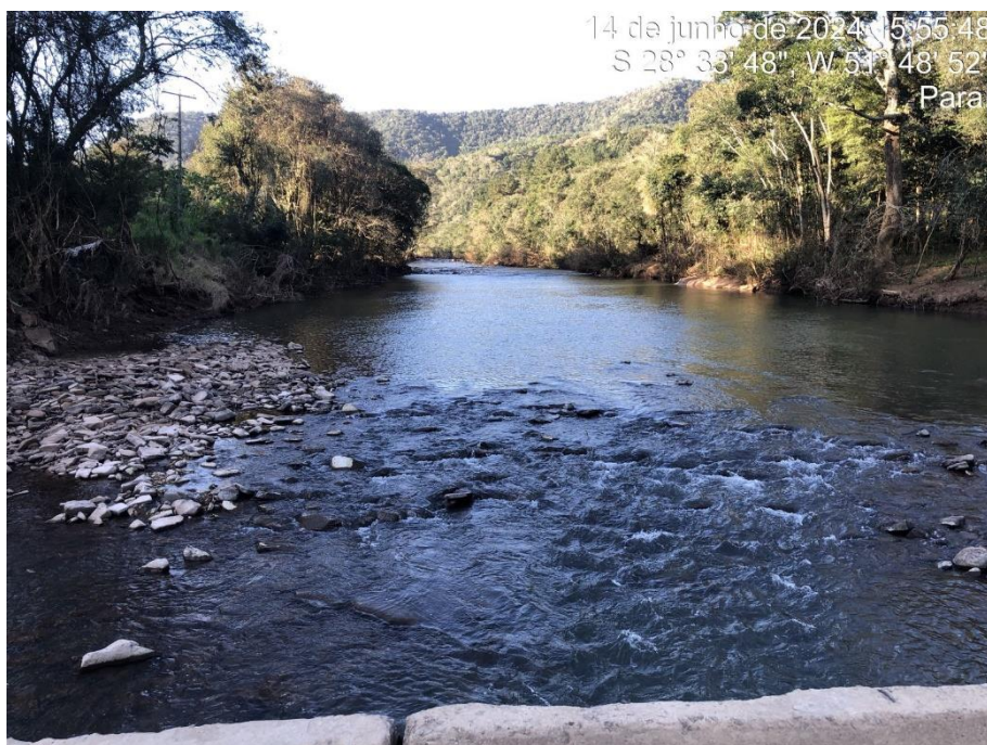
Imagem 02: Acúmulo de material no entorno da ponte;
