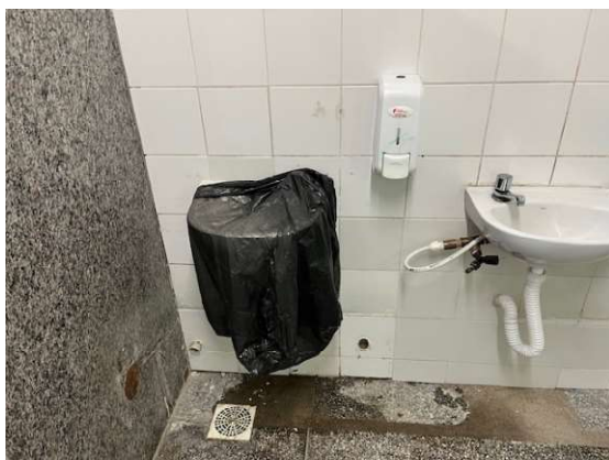
Exemplo de pias e vasos sanitários com problemas de funcionamento
