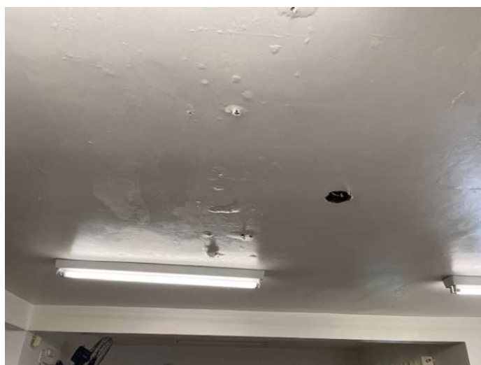
Exemplo de espelho cego a ser instalado no teto (Observa-se defeitos da pintura do teto, que deverá ser lixado e repintado)
