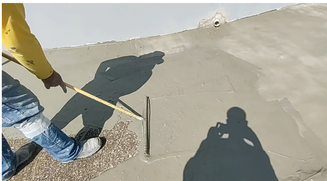
Exemplo da recuperação de calçada de concreto com nata de cimento
