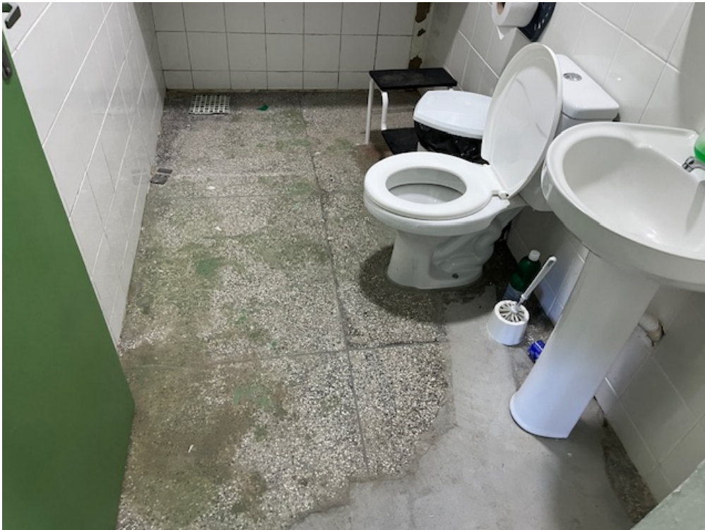
Exemplo de banheiro que deverá ter seu piso existente demolido e substituído por piso cerâmico
