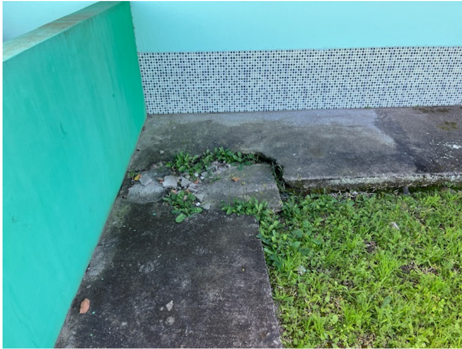
Detalhe de parte do pavimento que deverá ser cortado e recomposto
