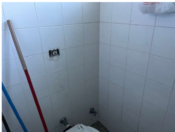
Exemplo de válvulas hydras a serem substituídas
