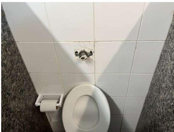
Exemplo de válvulas hydras a serem substituídas
