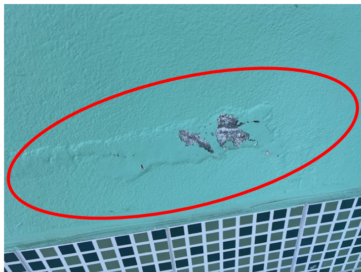
Exemplo de reboco comprometido a ser reparado
