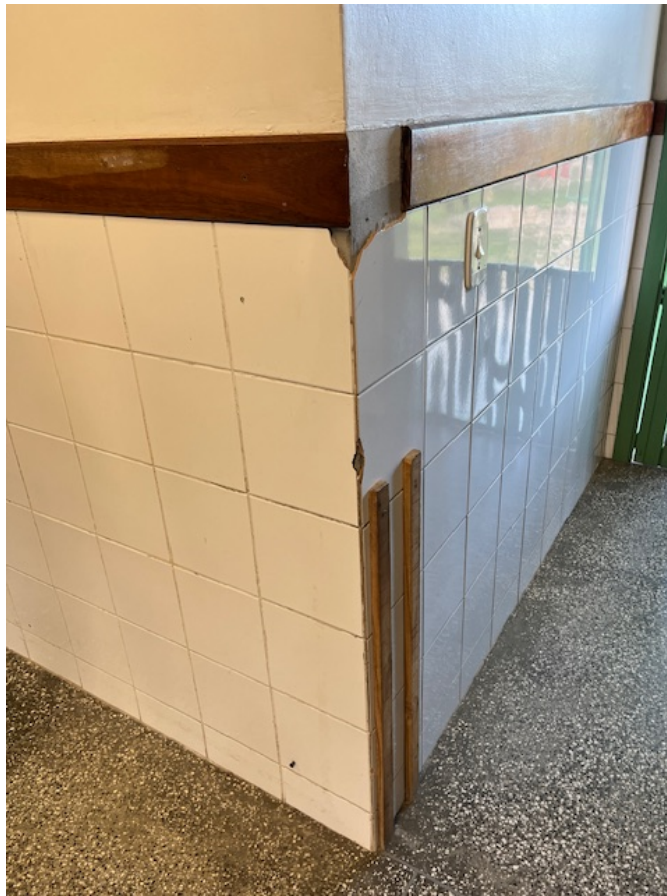
Exemplo de quina onde deverá ser instalado o perfil cantoneira
