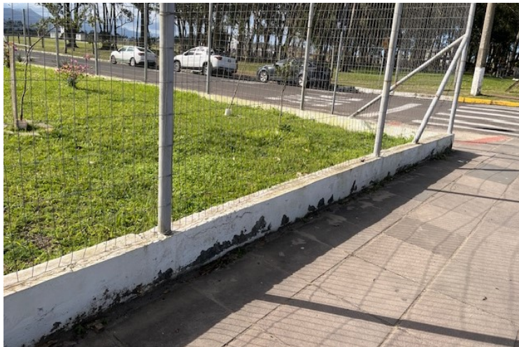
Viga a ser recuperada e pintada
