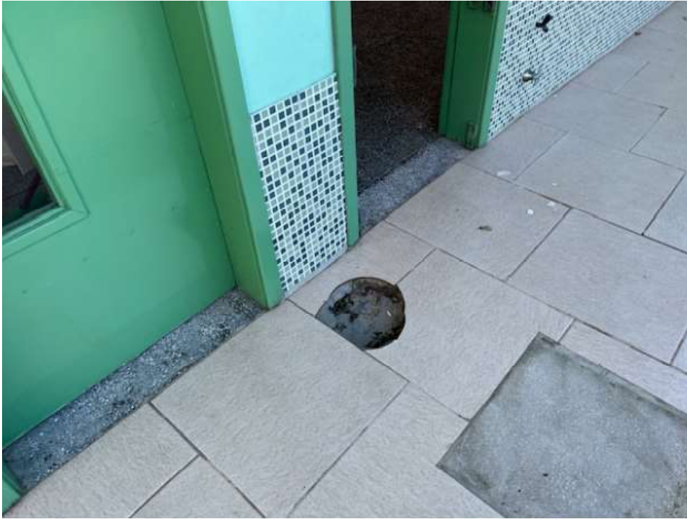
Exemplo de tampa a ser nivelada com o pavimento
