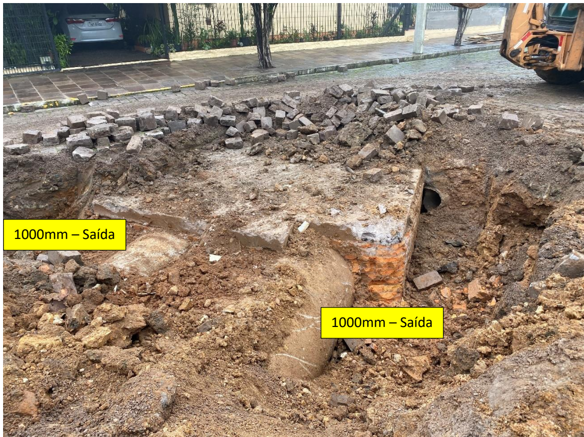
Caixa de passagem com 02 tubos de 1000mm de saída
