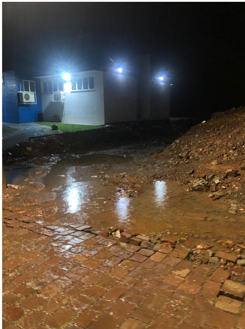
Escavação em terreno para abertura e escoamento do acúmulo de águas do Bairro Universal
