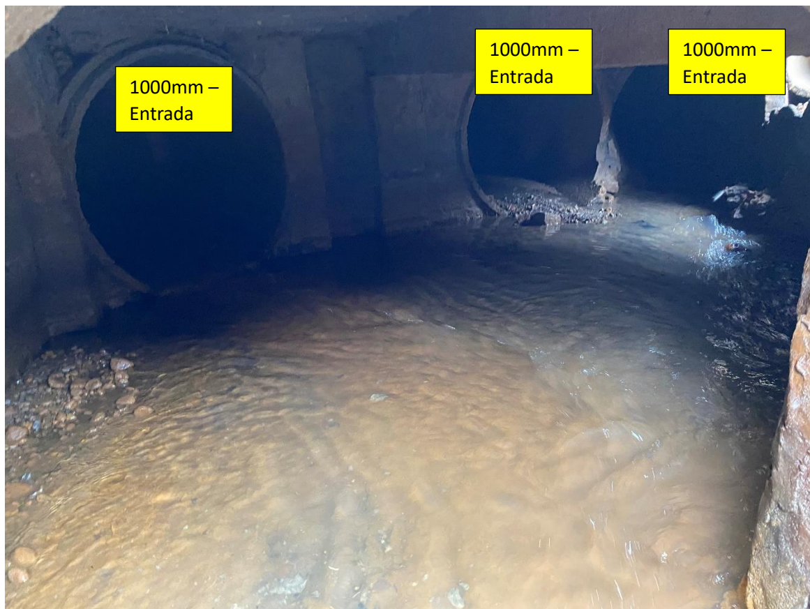
Caixa de passagem com 03 tubos de 1000mm de entrada
