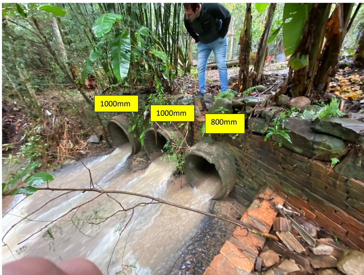
Final da tubulação pluvial, ligação com córrego existente fundos do ESF Universal
