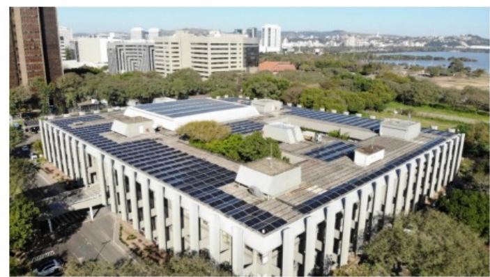
Figura 2: Foto da Usina 2
