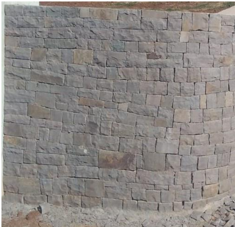
Figura 2.1.1: Imagem de exemplo da colocação das pedras
