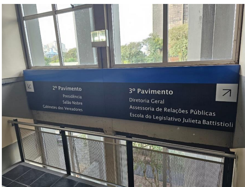
Figura 7 e 8: Sinalização presente nas escadas. Se possível, atualizar o conteúdo e cor mantendo a estrutura atual, que se encontra em bom estado e funcional.
