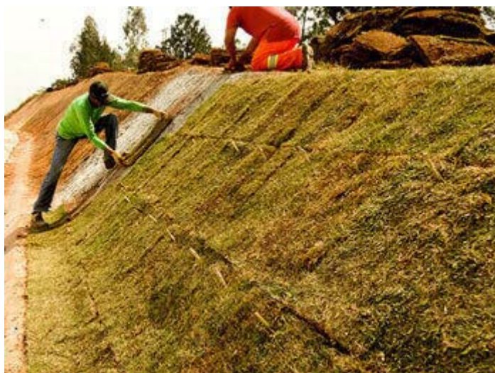
Figura 69 – Fixação com estacas de bambu
