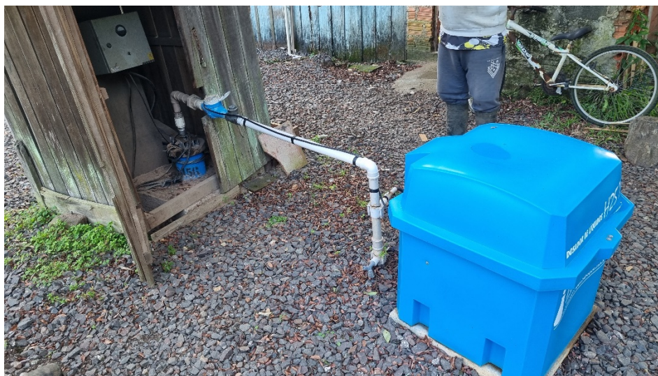
Figura 03: Estruturas instaladas. Poço, o hidrômetro e o clorador.
