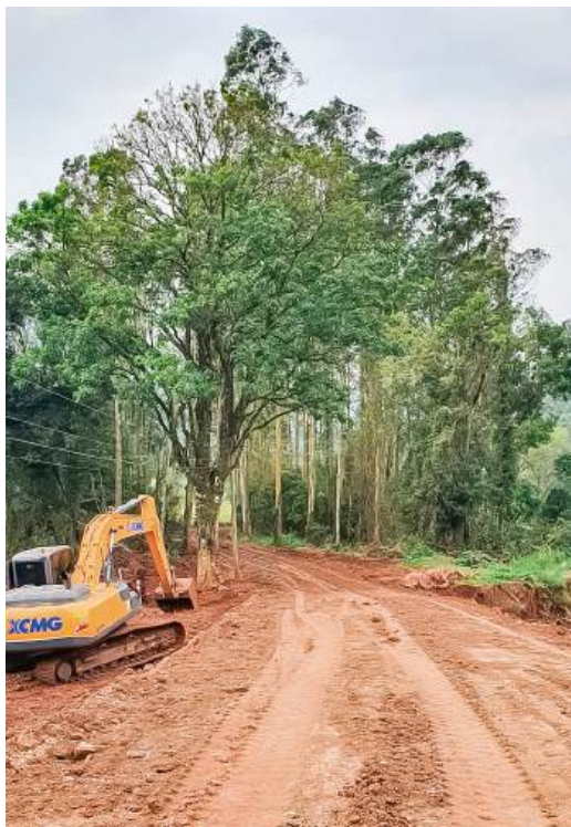
Ponte na divisa de Bom Princípio e São Vendelino: trecho liberado para passagem de veículos
