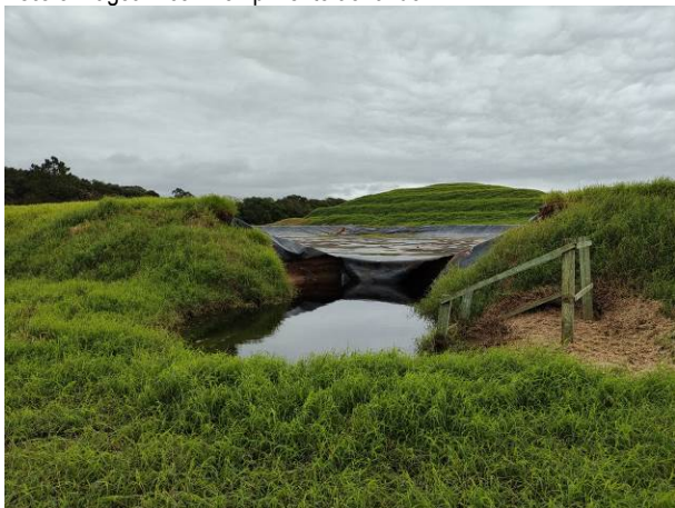
Foto 11. Talude rompido na lagoa 1.
