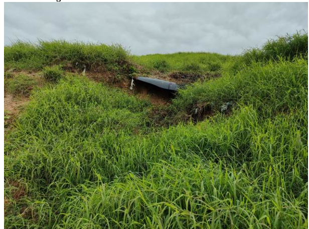
Foto 21. Erosão no talude leste da célula 4.
