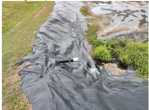
Foto 10. Tubulação de entrada de efluente na lagoa 1.
