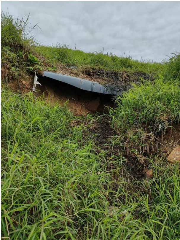
Foto 20. Erosão no talude leste da célula 4.
