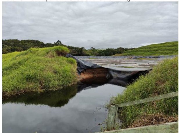
Foto 12. Talude rompido na lagoa 1 e acúmulo de água/lixiviado e geomembrana danificada.
