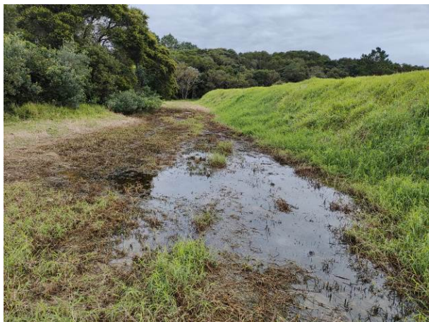
Foto 12. Lixiviado escoado e acumulado devido ao rompimento.
