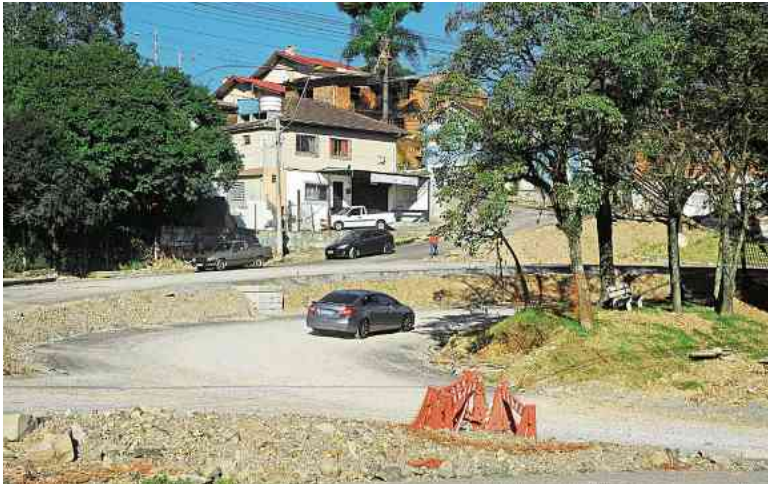
Trânsito no local foi liberado mesmo em meio ao canteiro de obras
