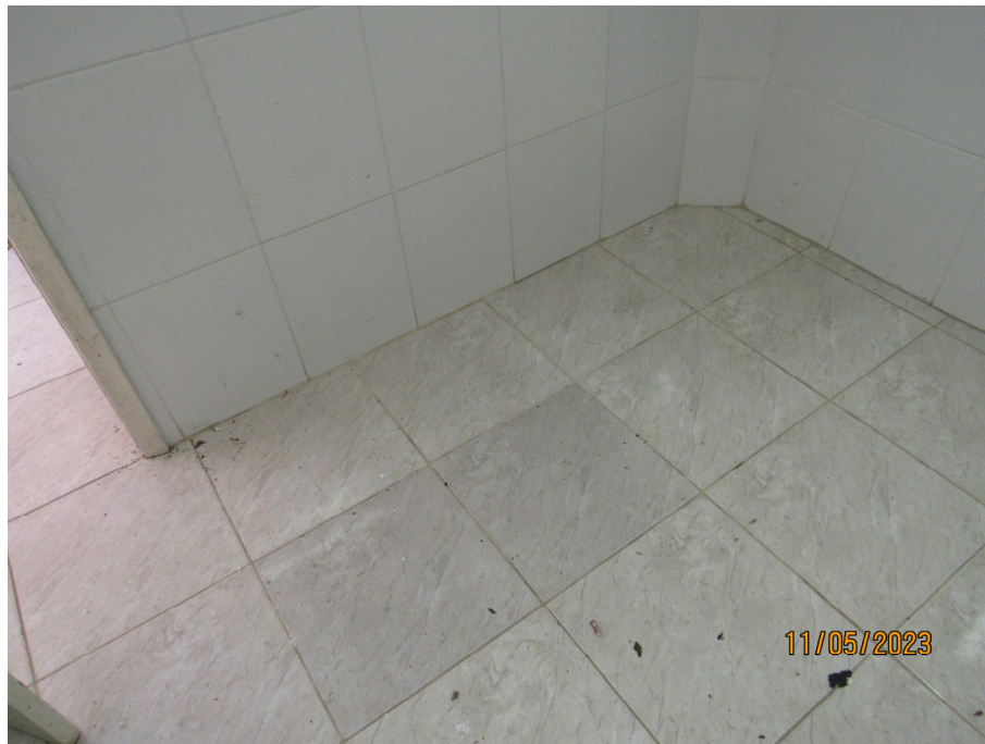
Fig. 28: Piso com indícios de troca e som cavo.
