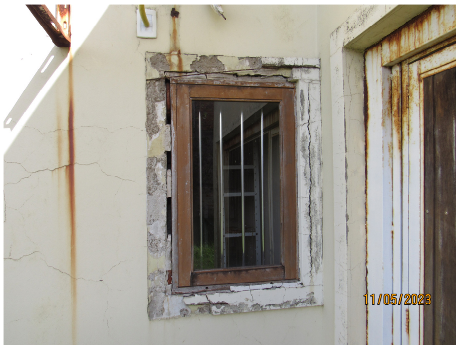
Fig. 36: Moldura deslocada com indícios de corrosão.
