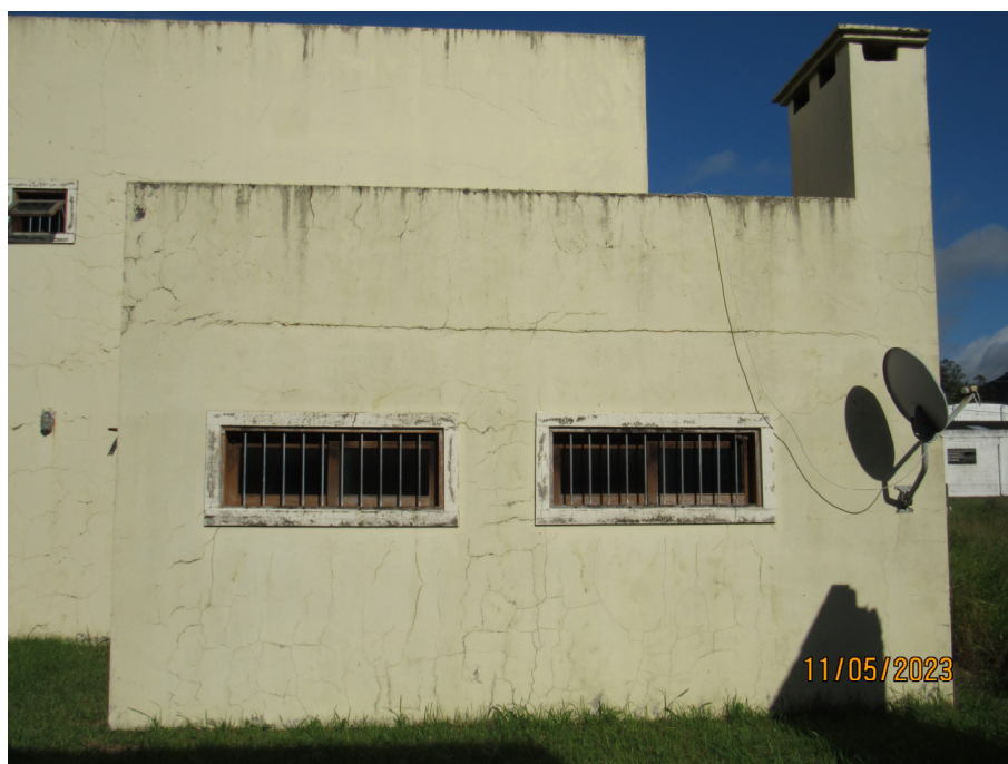
Fig. 10 – Fissura por flexão simples
