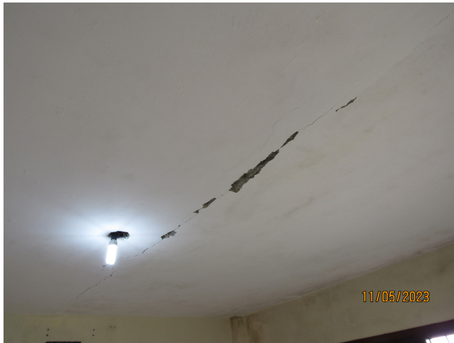
Fig. 16: Fissuras em laje de forro.
