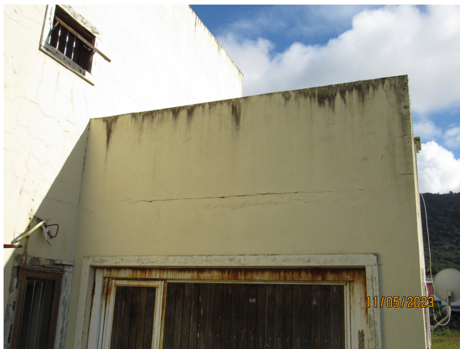
Fig. 23: Fissura devido à movimentação térmica.
