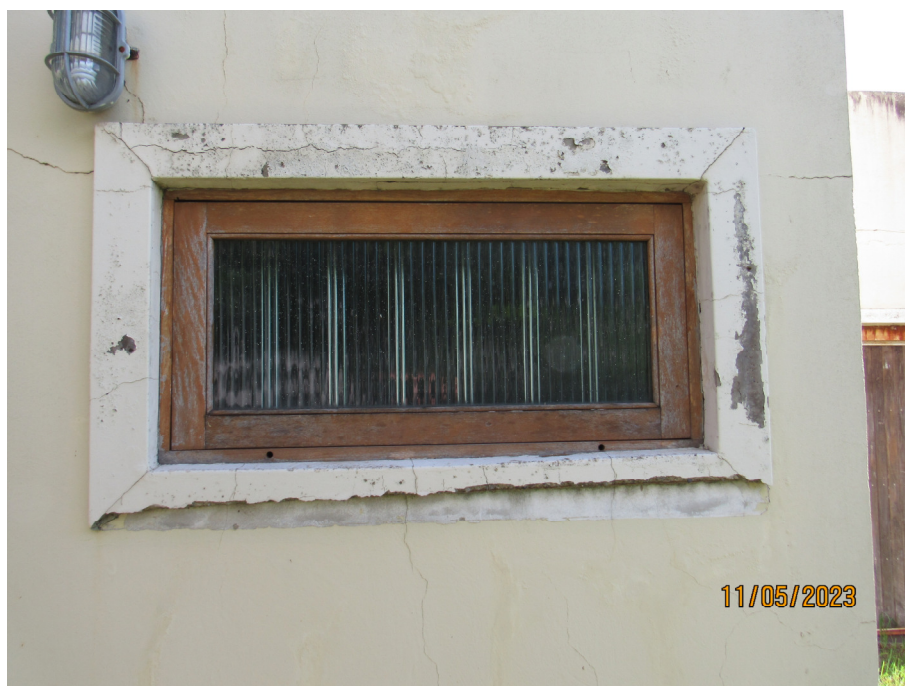
Fig. 36: Moldura de janela de WC com fissuras e deslocamentos.
