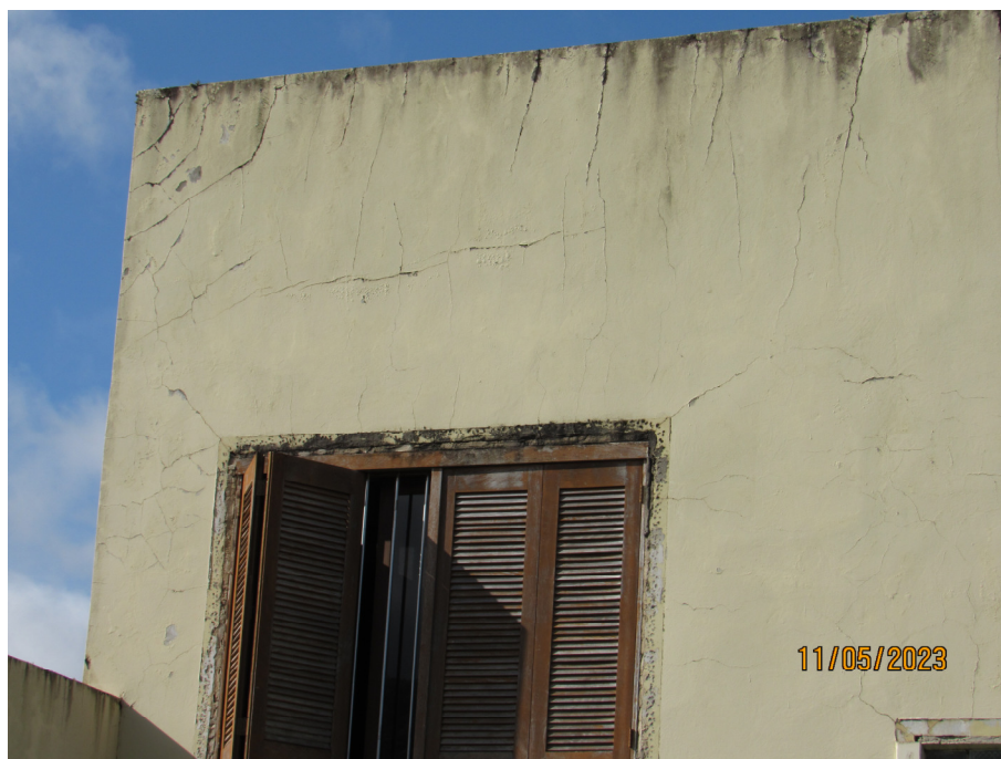
Fig. 31: Microfissuras.
