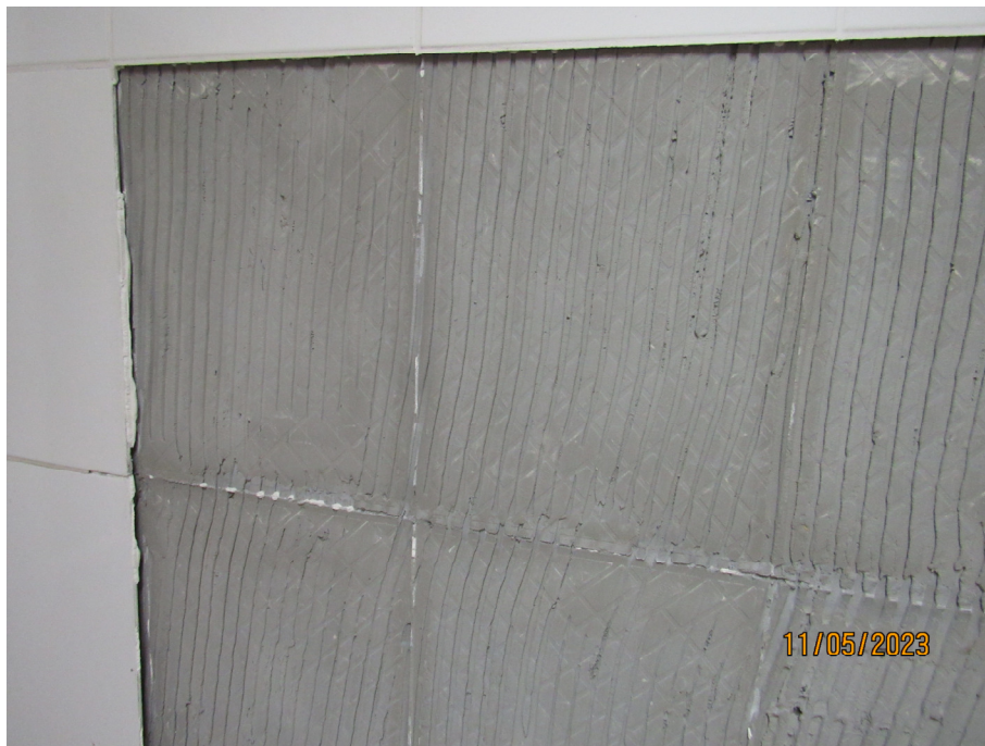
Fig. 27: Detalhe de argamassa colante não aderida em peça cerâmica.
