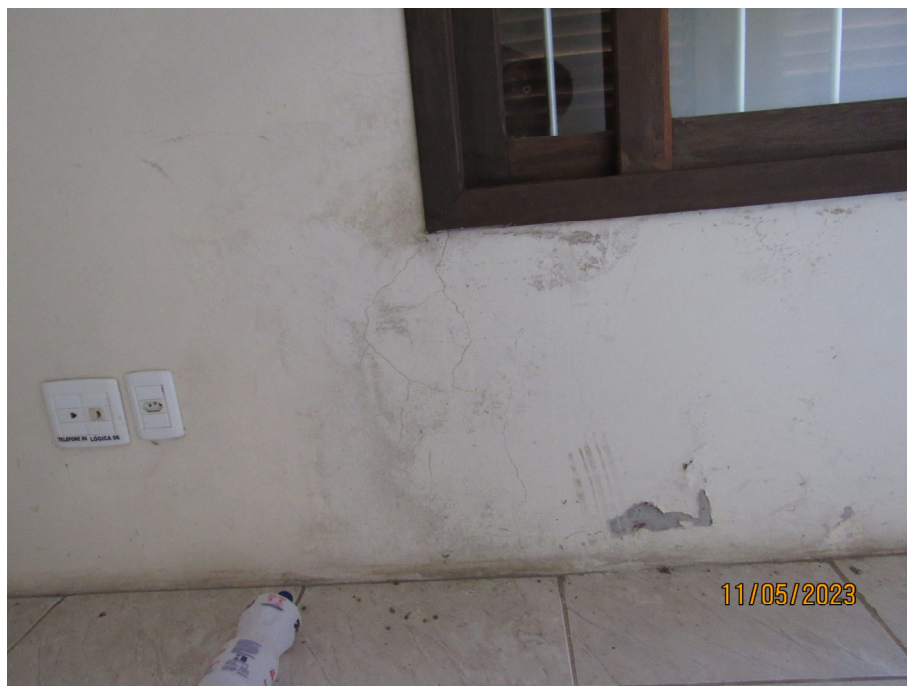
Fig. 41: Fissuras e infiltrações ocasionadas por umidade em falha de pingadeiras.
