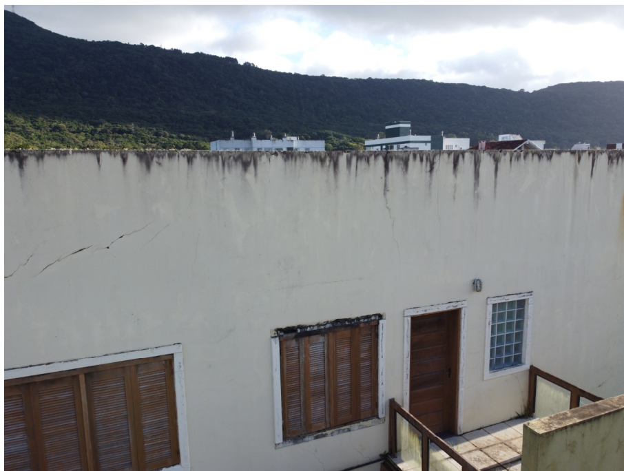
Fig. 43: Alvenaria de platibanda sem capa de muro.
