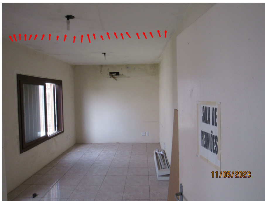
Fig. 17: Detalhe de fissura em laje de forro.
