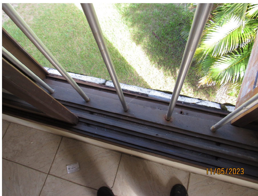
Fig. 39: Falha na pingadeira de janela.
