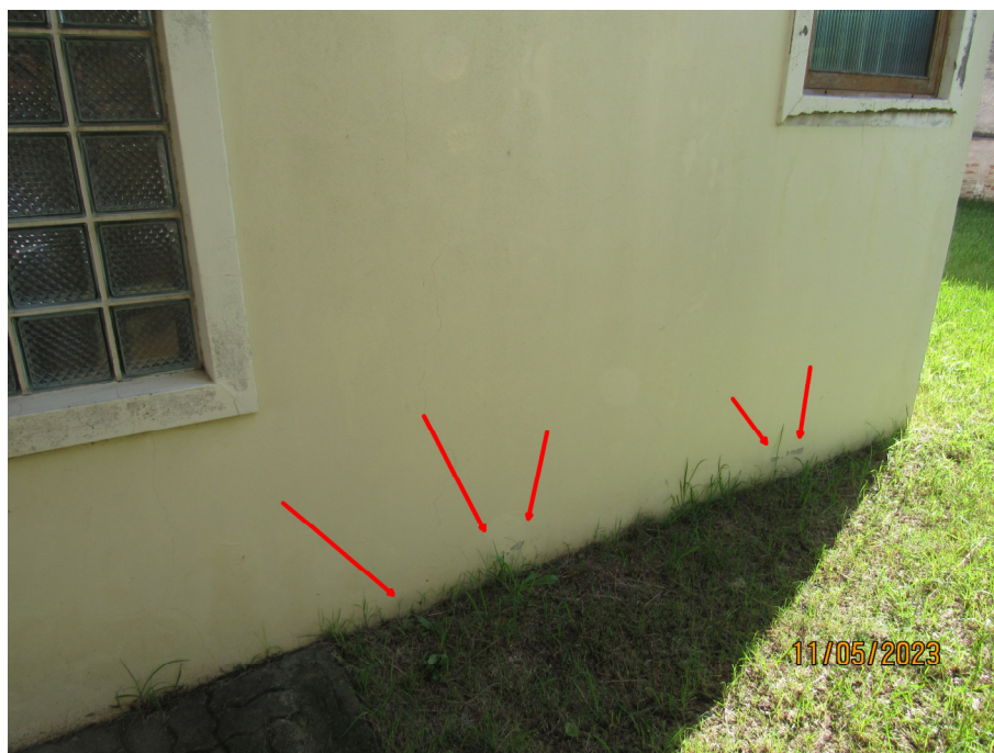
Fig. 07 – Pontos com fissuras devido a infiltração por capilaridade
