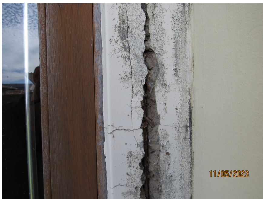
Fig. 37: Moldura com corrosão.
