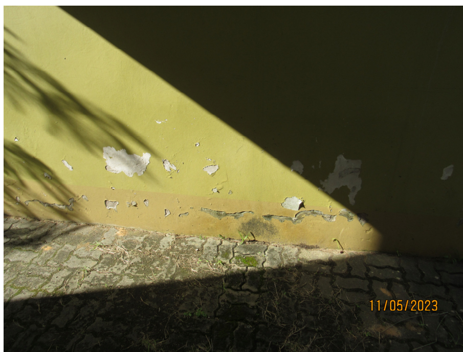
Fig. 08 – Fissuras e deslocamento por capilaridade e acúmulo de umidade.
