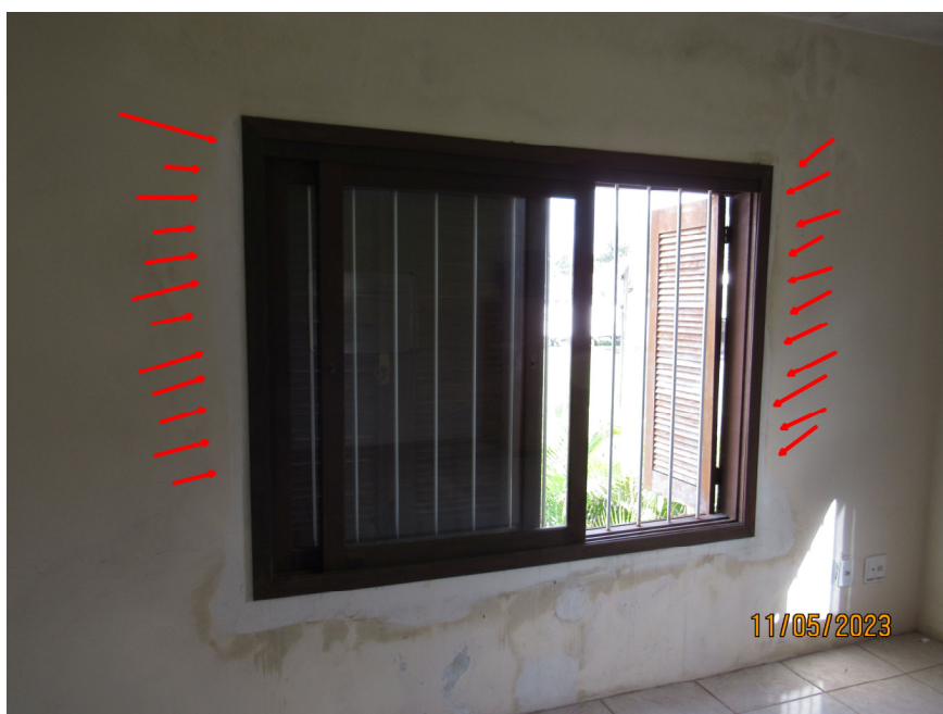
Fig. 38: Indícios de reparos de infiltrações internas.
