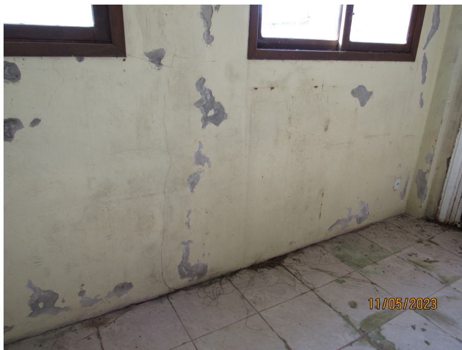
Fig. 15: Movimentação de base e fissuras generalizadas.
