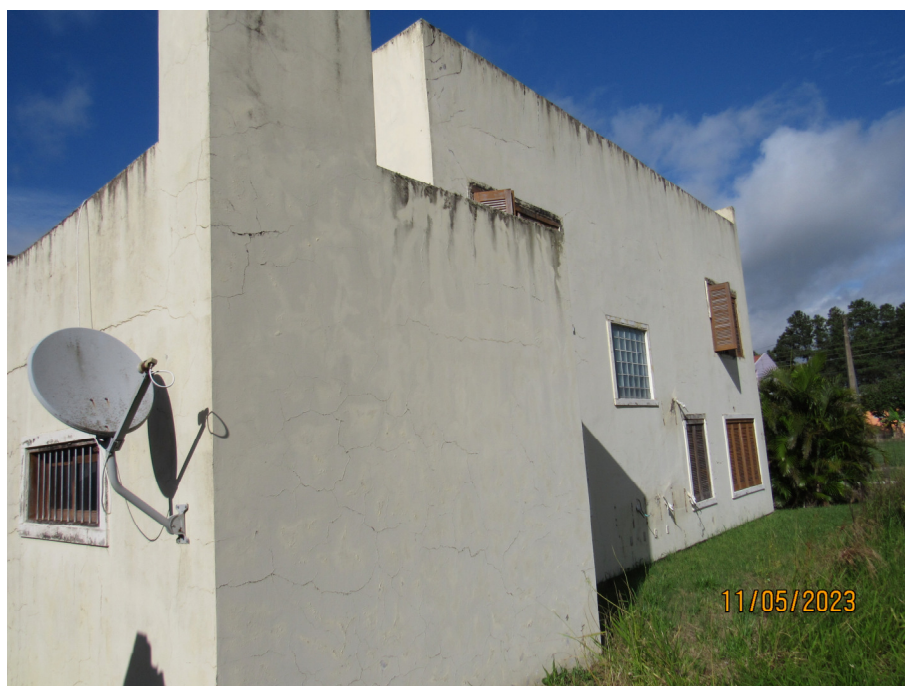
Fig. 30: Fissuras Higrotérmicas.
