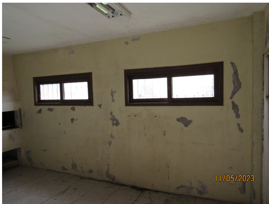
Fig. 14: Parede com fissurações generalizadas.
