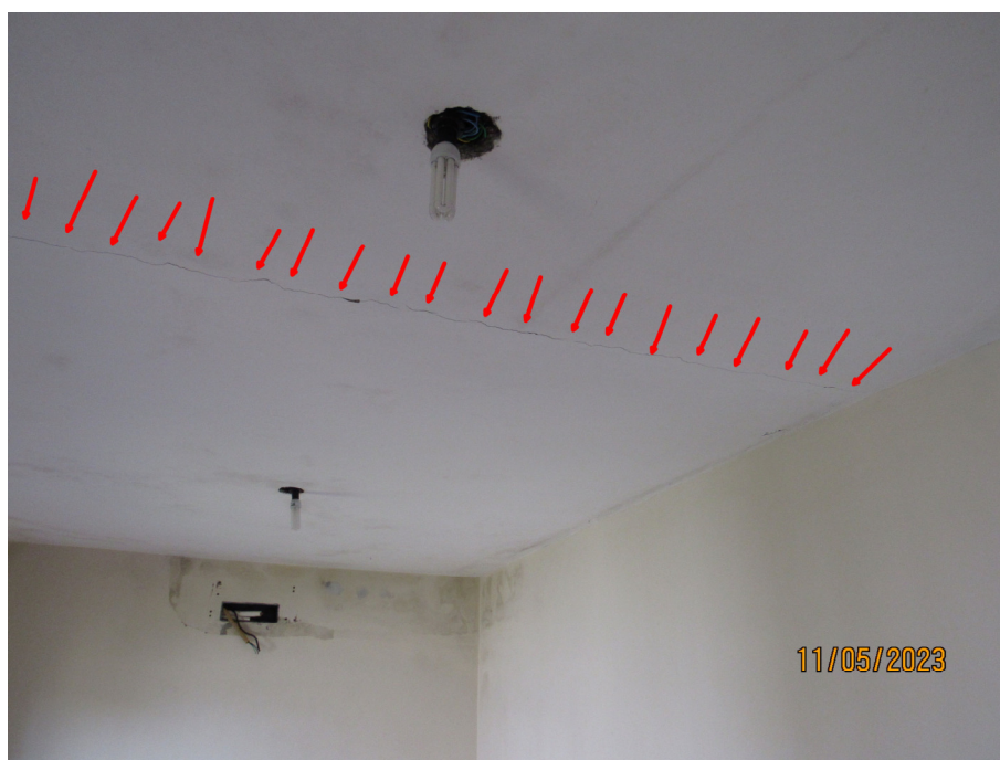
Fig. 18: Detalhe de fissura em laje no sentido longitudinal ao elemento pré-fabricado.
