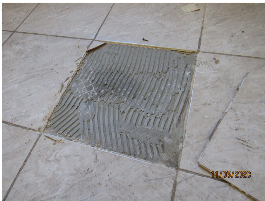
Fig. 29: Detalhe de argamassa colante não aderida em peça cerâmica de piso.
