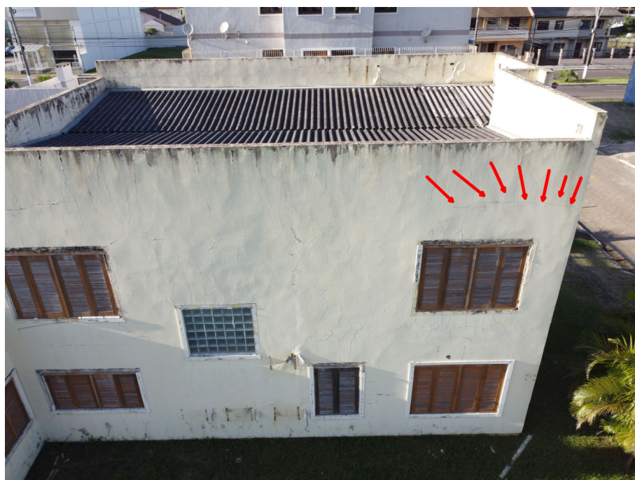
Fig. 24: Fissura devido à movimentação térmica de laje de cobertura – Fachada Norte.
