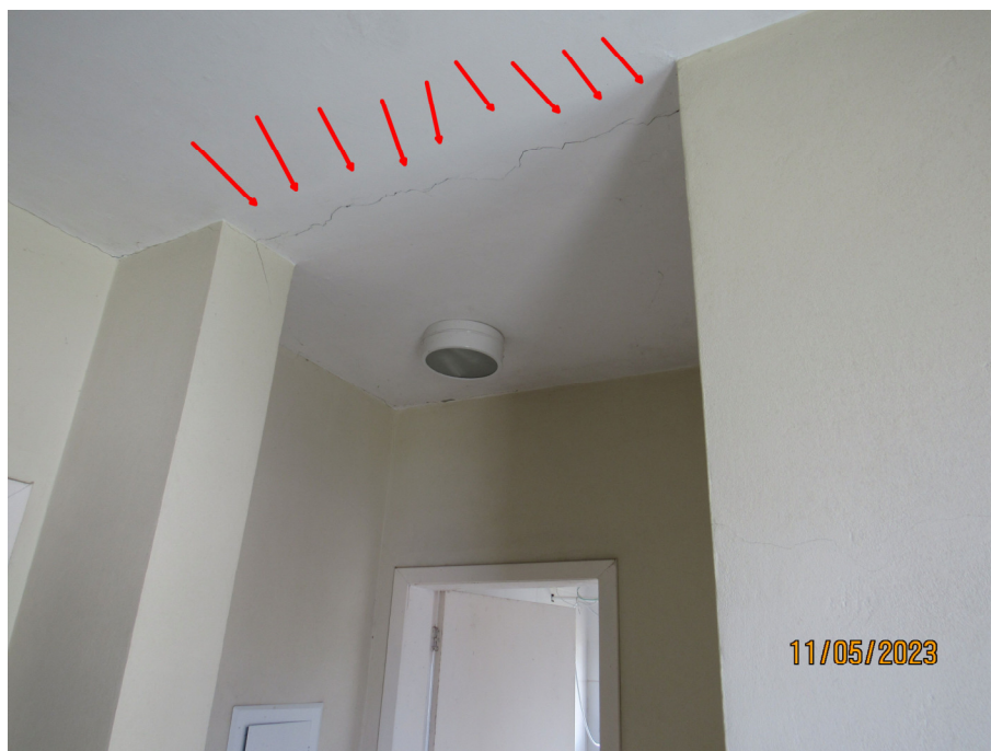
Fig. 21: Fissura em encontro de lajes.
