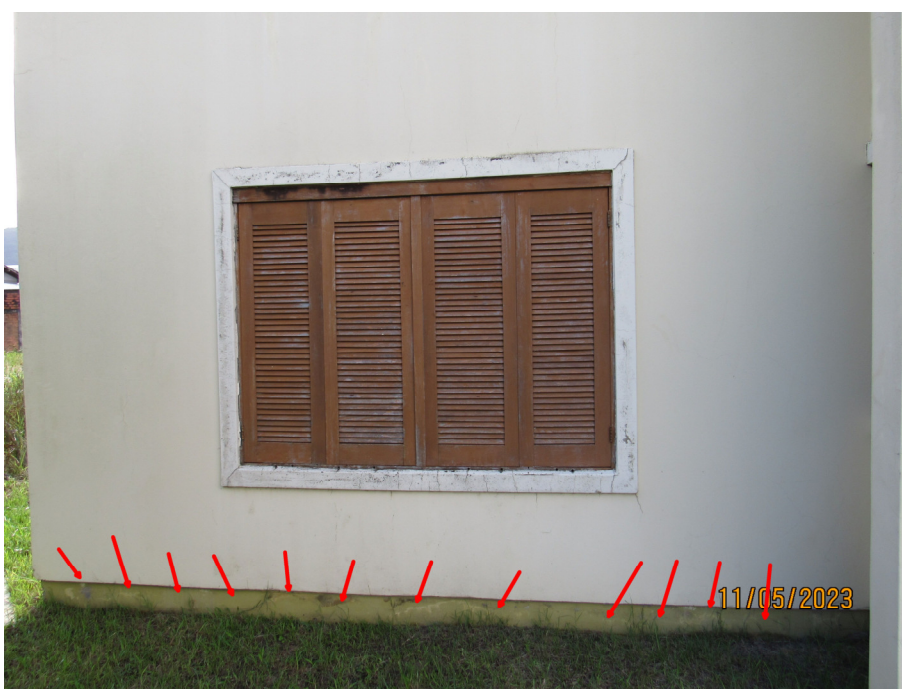
Fig. 06 – Infiltrações por capilaridade
