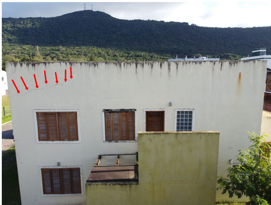
Fig. 25: Fissura devido à movimentação térmica de laje de cobertura – Fachada Sul.
