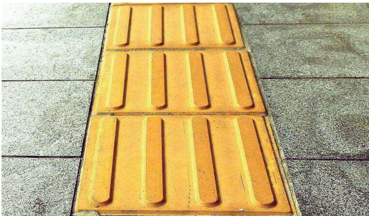
Figura 2. Exemplo de piso tátil em passeio.
