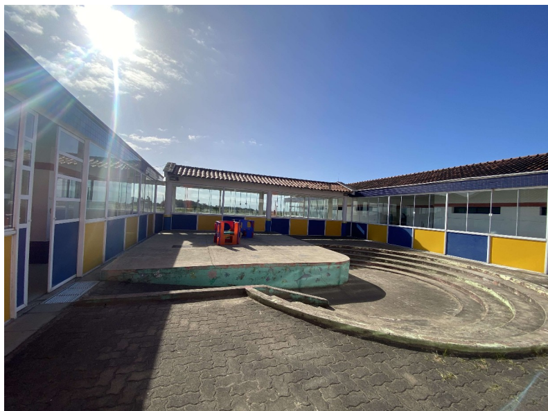
Figura 1: Pátio externo, anfiteatro e fechamento em vidro da edificação existente.
