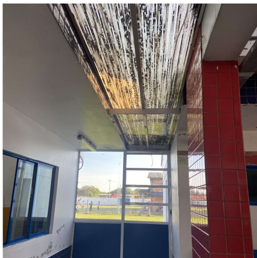
Figura 2: Cobertura em policarbonato existente.
