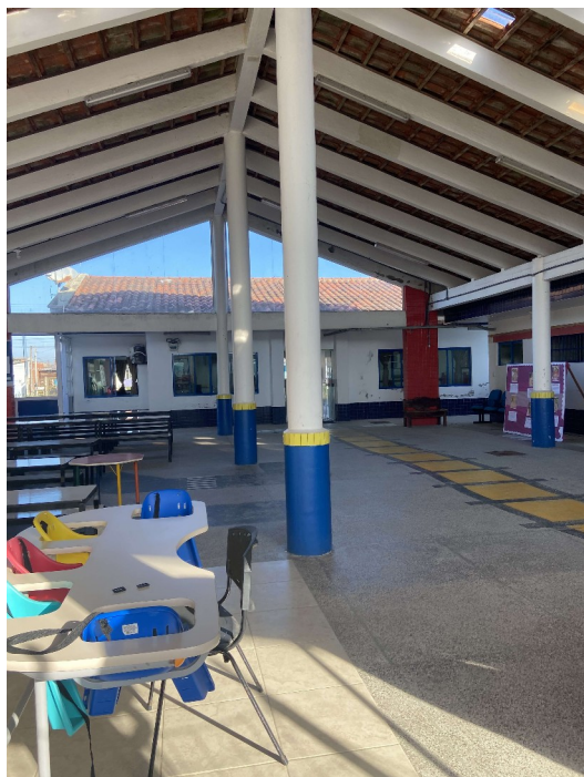
Figura 5: Pilares do pátio coberto existente.
