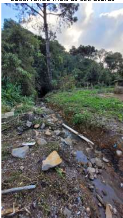
Figura 3 – Tubulação utilizada provavelmente para lançamento dos esgotos diretamente no corpo receptor
