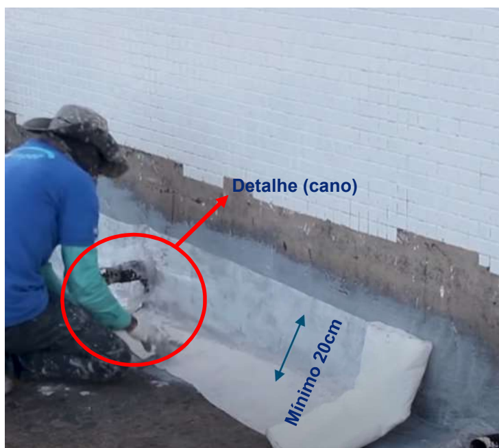
Figura 12- Impermeabilização de laje e rodapé
