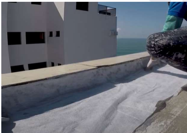
Figura 11- Impermeabilização de laje e rodapé
