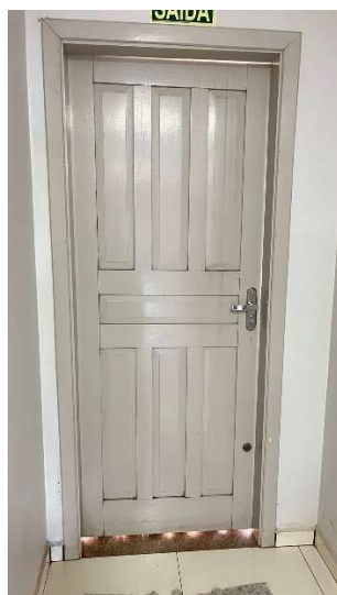
Figura 15 – Porta da circulação a ser retirada
