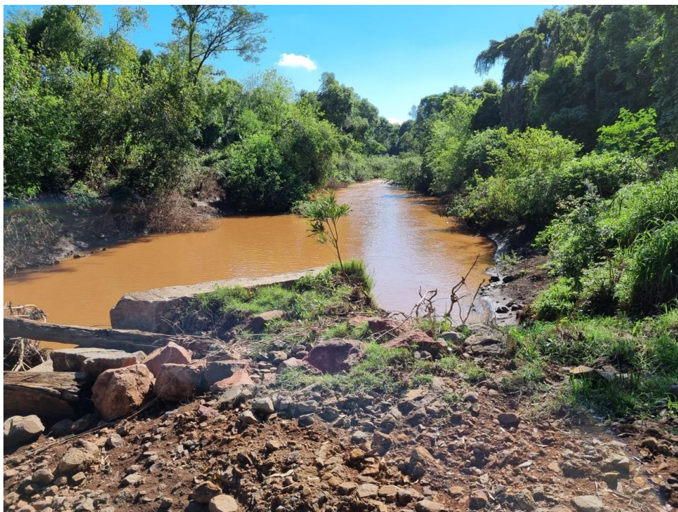
Figura 8: Situação Atual da Ponte Freisleben
