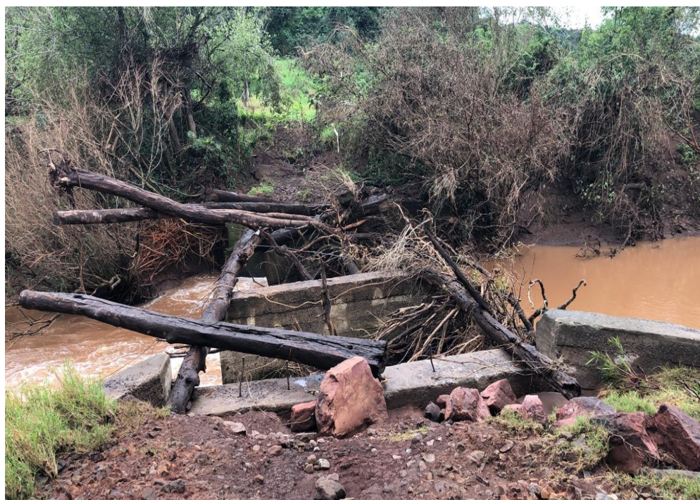
Figura 5: Situação Atual da Ponte Freisleben
