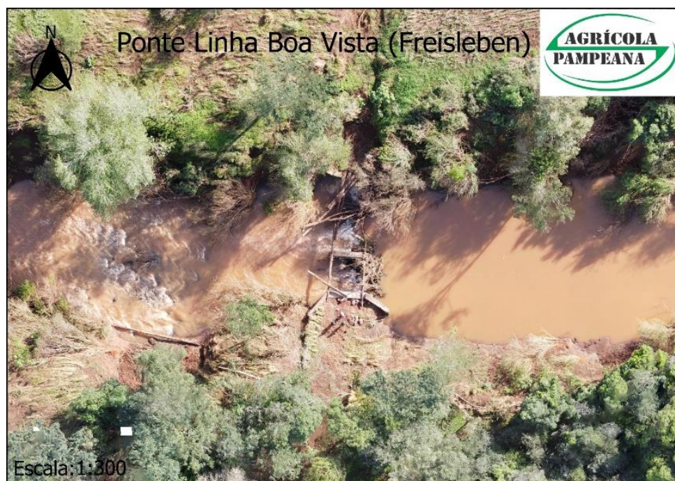
Figura 4: Situação Atual da Ponte Freisleben
