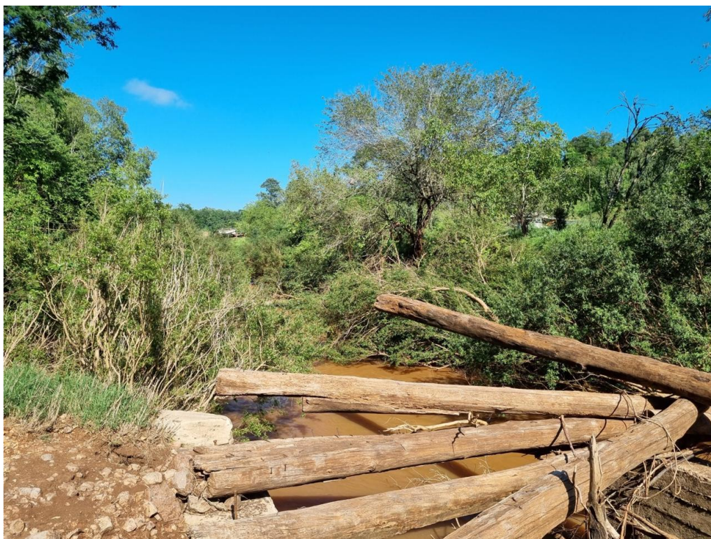
Figura 7: Situação Atual da Ponte Freisleben
