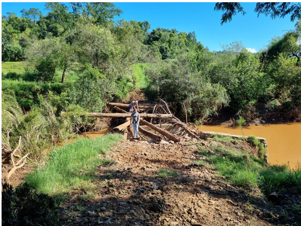
Figura 6: Situação Atual da Ponte Freisleben
