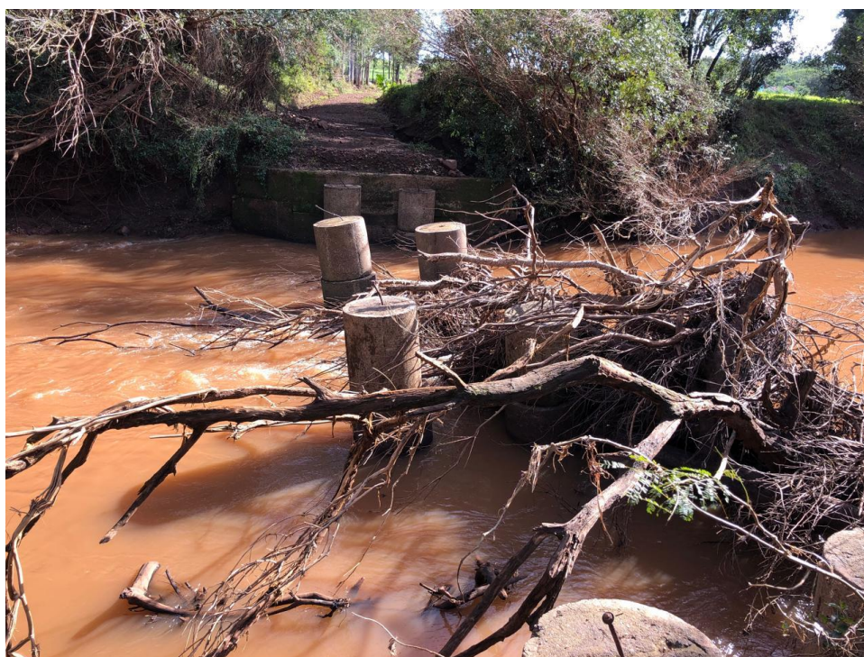
Figura 5: Situação Atual da Ponte Sede
