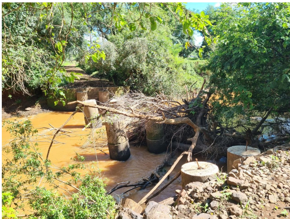
Figura 7: Situação Atual da Ponte Sede
