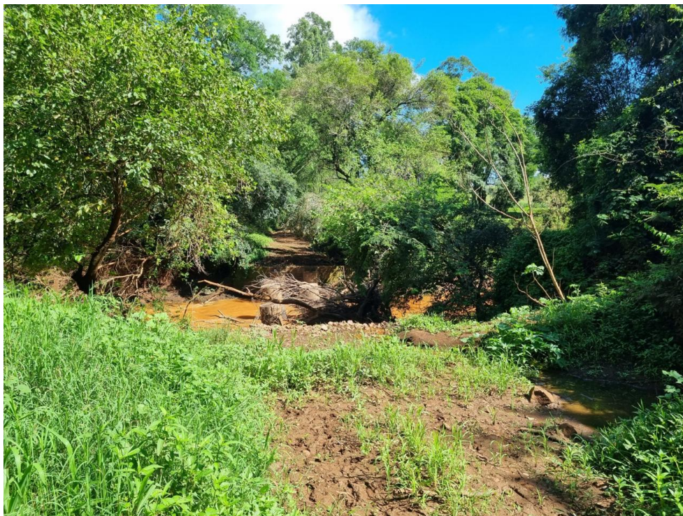
Figura 6: Situação Atual da Ponte Sede
