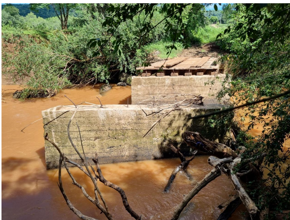
Figura 6: Situação Atual da Ponte Granja Ost
