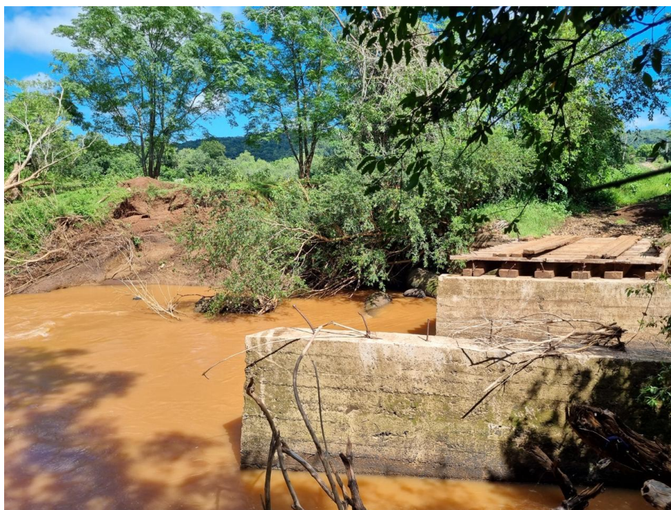
Figura 8: Situação Atual da Ponte Granja Ost
