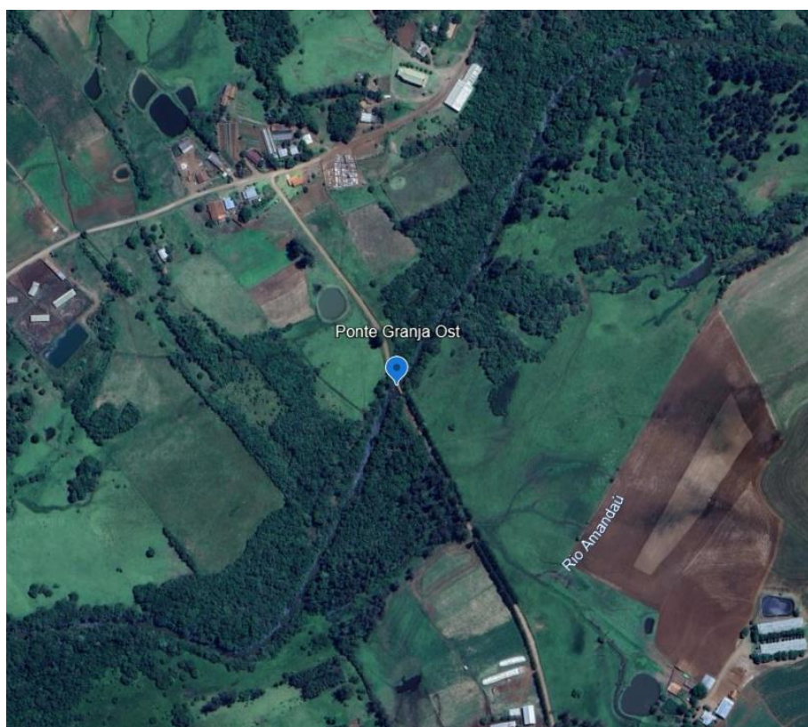
Figura 3: Localização da Ponte Granja Ost
