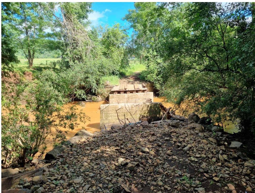
Figura 7: Situação Atual da Ponte Granja Ost
