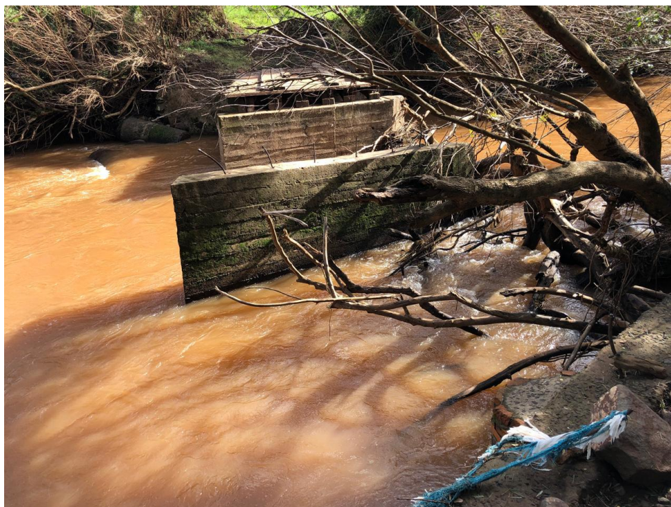
Figura 5: Situação Atual da Ponte Granja Ost
