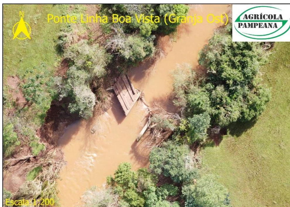
Figura 4: Situação Atual da Ponte Granja Ost
