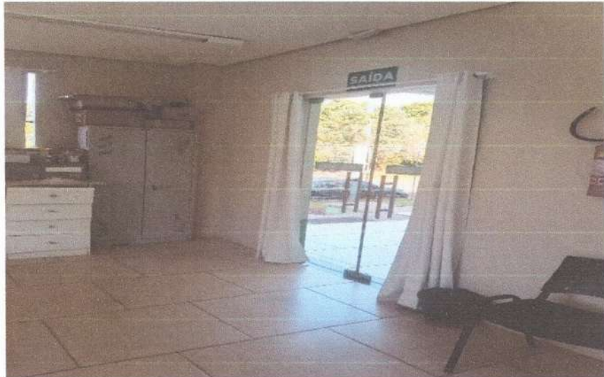
Figura 3: Porta a ser retirada para ampliação do ambiente
