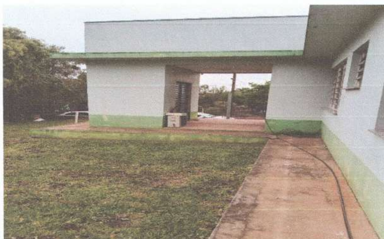
Figura 17: Local onde será feito ampliação do prédio
