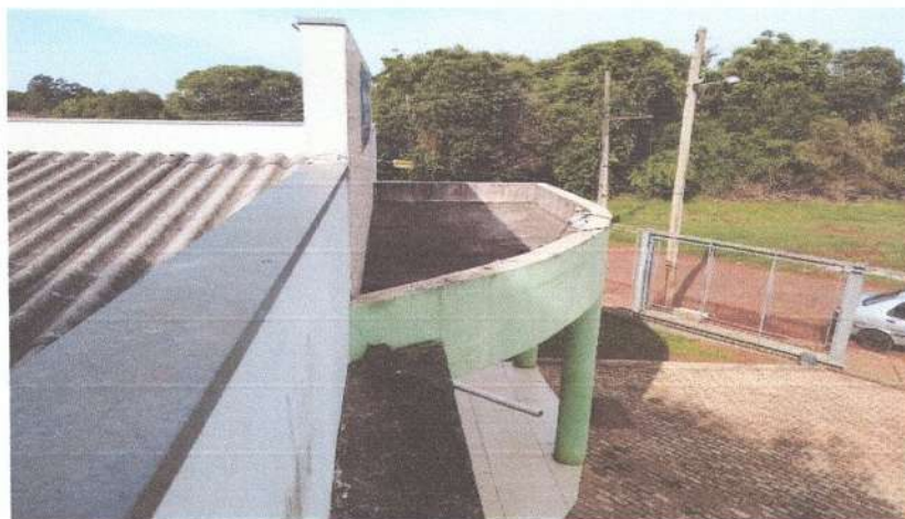
Figura 18: Cano a ser canalizado no pilar arquitetônico.
