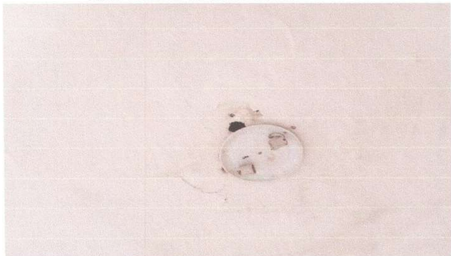
Figura 4: Forro da Varanda de Entrada
