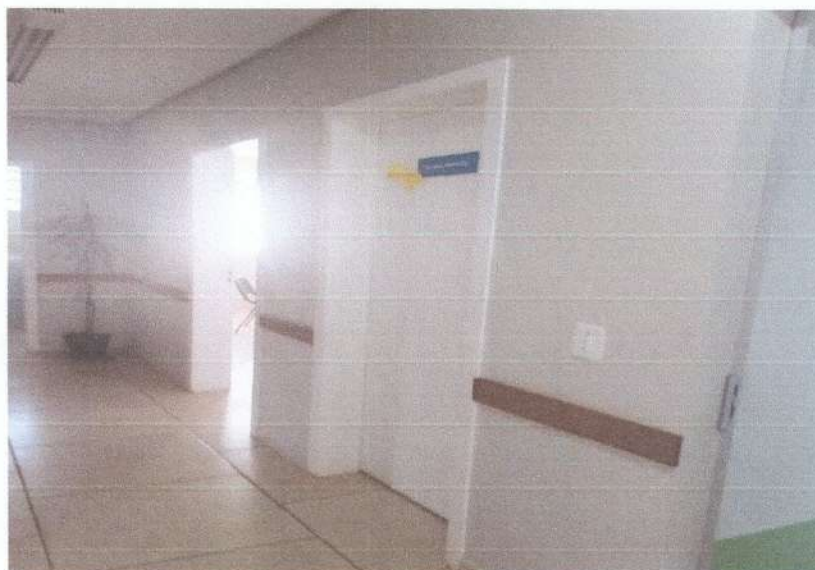
Figura 13: Entrada Almoxarifado - Fechamento porta
