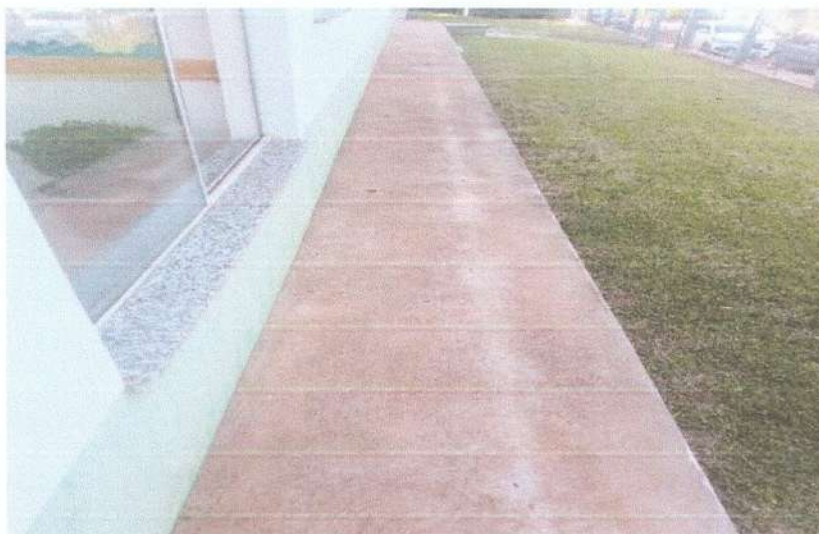
Figura 19: Contrapiso a ser revestido com cerâmica
