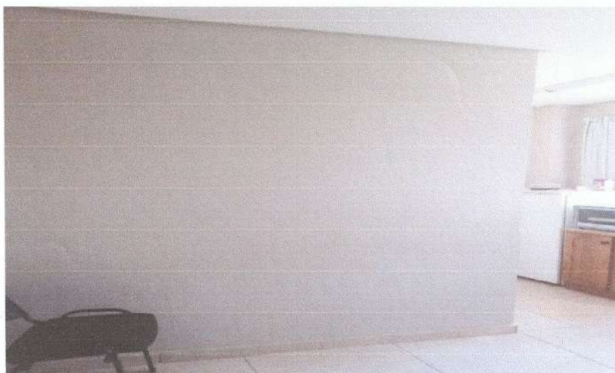
Figura 14: Paredes banheiro a ser removidas
