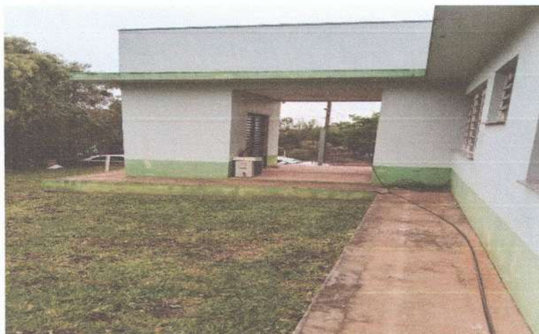
Figura 17: Local onde será feito ampliação do prédio
