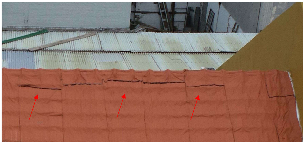
Imagem 13 – Rasgos na manta asfáltica
