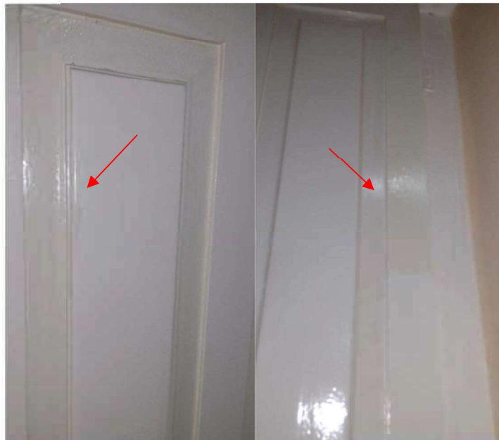
Imagem 9 – Amarelamento da tinta de acabamento das esquadrias de madeira.
