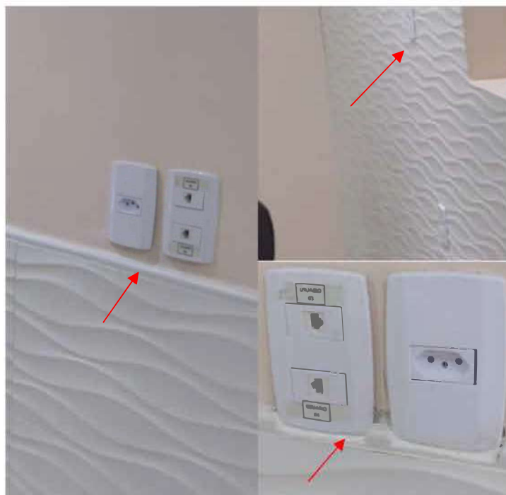
Imagem 4 – Tomadas médias desalinhadas horizontalmente.
