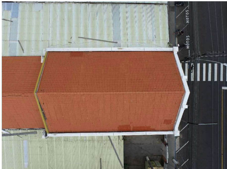
Imagem 20 – Vista superior do telhado com platibanda da Biblioteca Municipal
