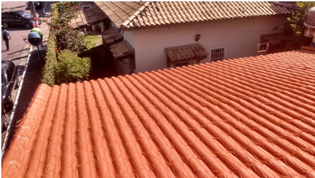
Exemplo de impermeabilização com manta asfáltica sobre telha portuguesa
