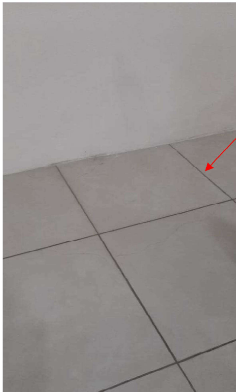
Imagem 20 – Água acumulada no piso oriunda da cobertura
