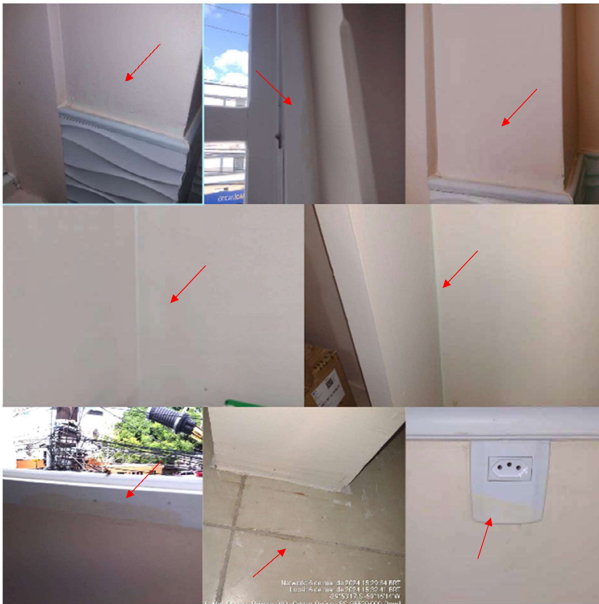
Imagem 7 – Pontos com imperfeição no acabamento da pintura, manchas e respingos.
