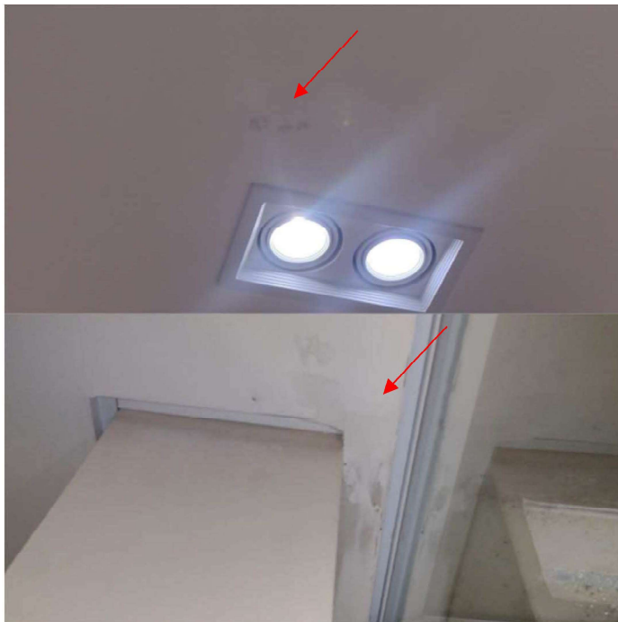
Imagem 8 – Pontos no forro com imperfeição no acabamento da pintura.
