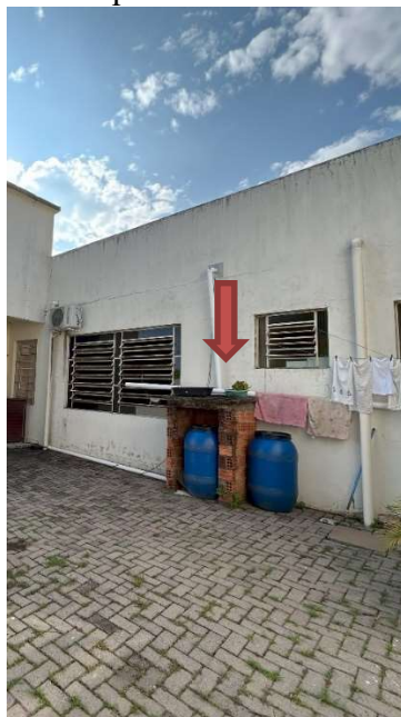
Imagem abrigo de gás a ser demolido
