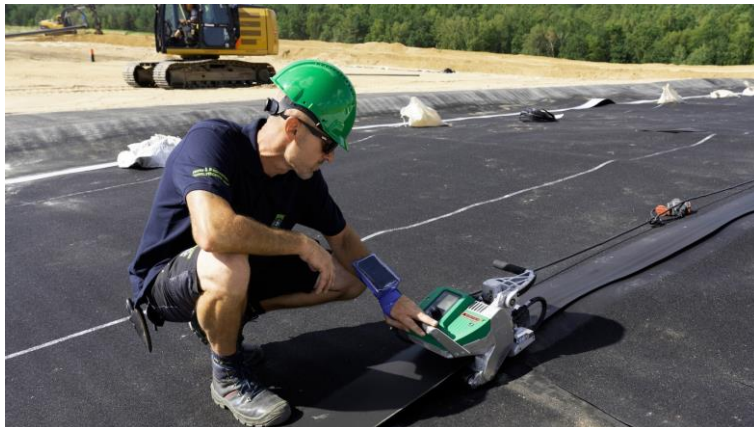
Imagem de soldagem de mantas geomembrana PEAD 1,0 mm;
