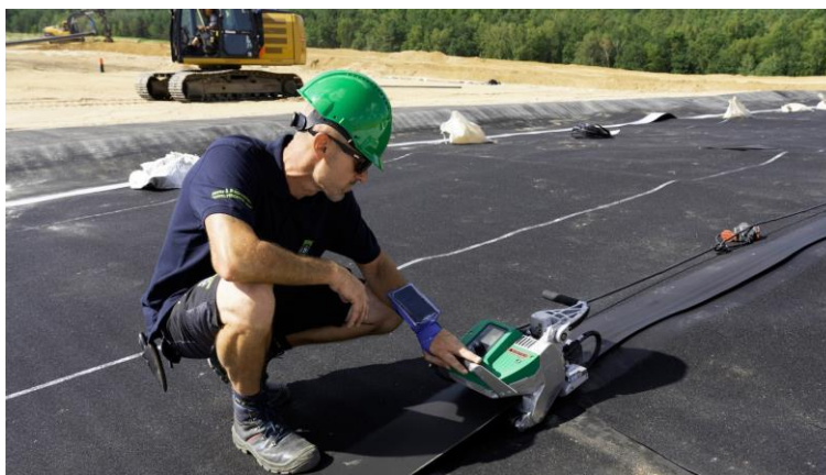
Figura 15 – Imagem de soldagem de mantas geomembrana PEAD 1,0 mm;
