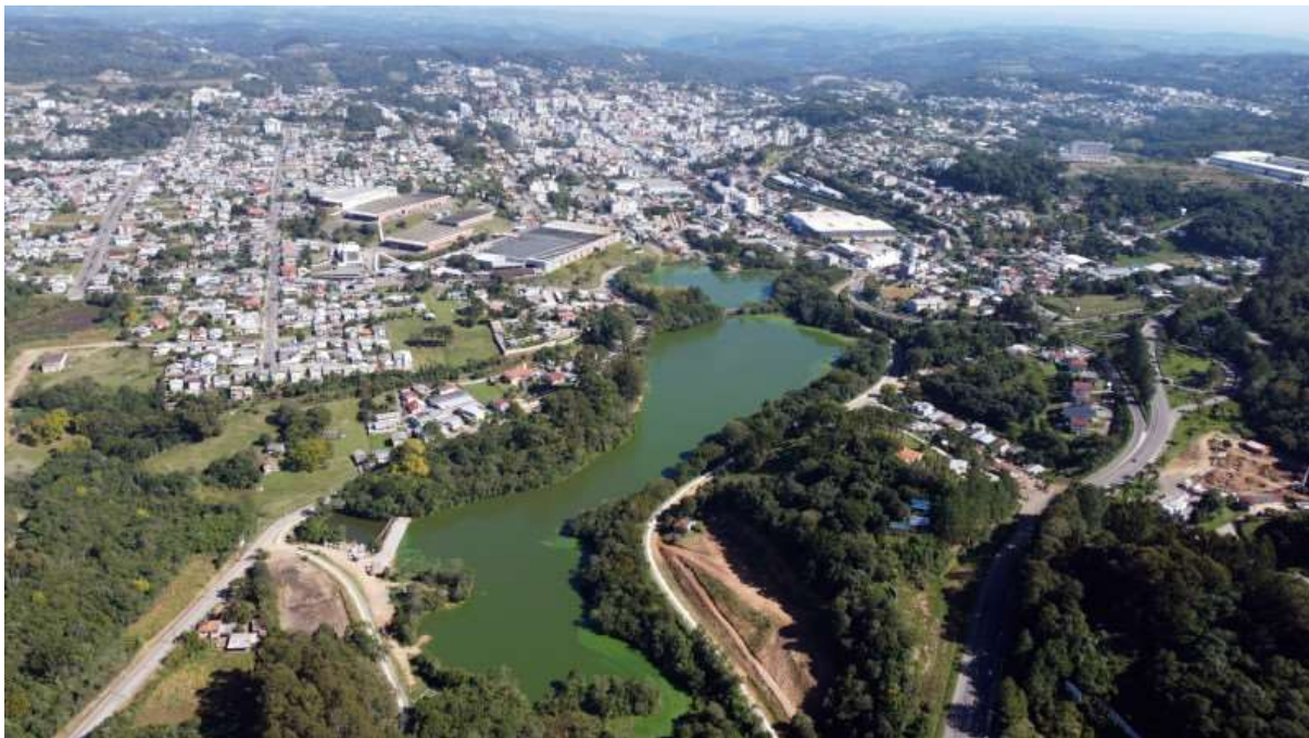
Figura 1. Fotografia da Barragem do Arroio Marrecão. Garibaldi, RS.
