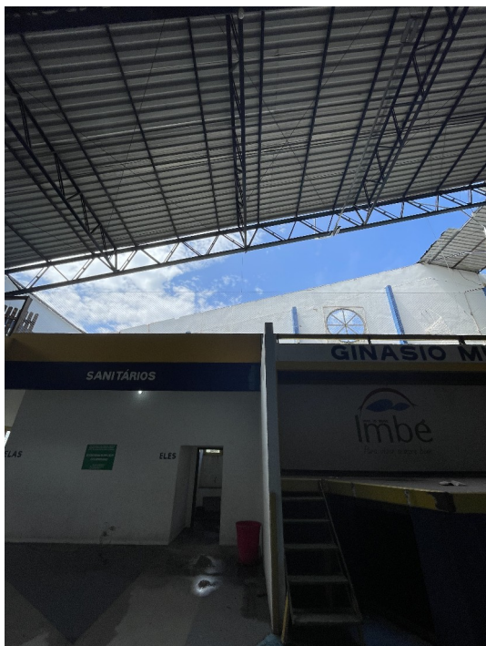
Figura 1: Área destelhada e local da nova escada
