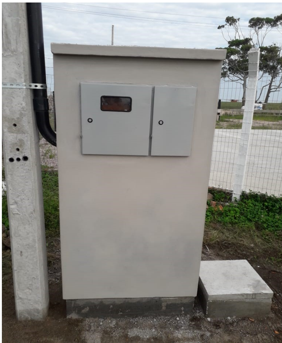
FOTO 1: Vista frontal da Mureta de medição, foto ilustrativa.
