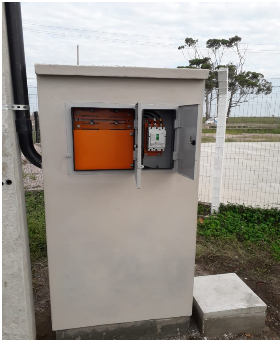
FOTO 2: Vista Frontal da mureta de medição, parte interna.
