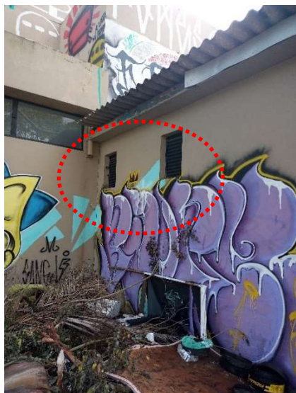
Foto 13: Janelas a serem removidas da Subestação
