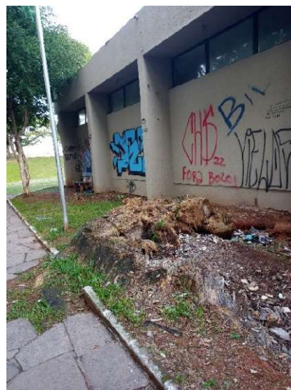
Foto 18: Remoção de raízes remanescentes
