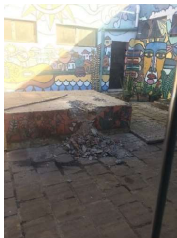
Foto 05: Demolição de volume Pátio Interno
