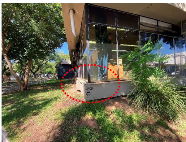
Foto 09: Ponto a ser removidos os pedacos de soleira
