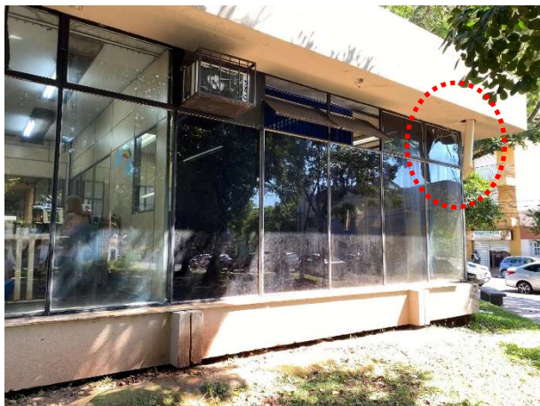
Foto 23: Furo na platibanda a ser fechado
