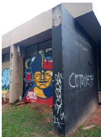
Foto 10: Revestimento preto a ser removido
