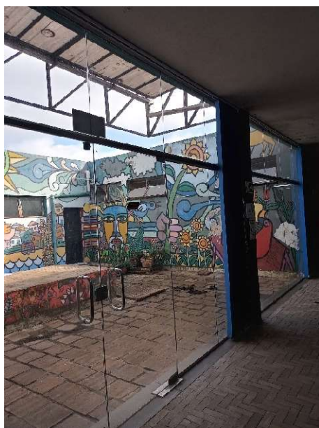
Foto 28: Soleira padrão do Pátio Interno
