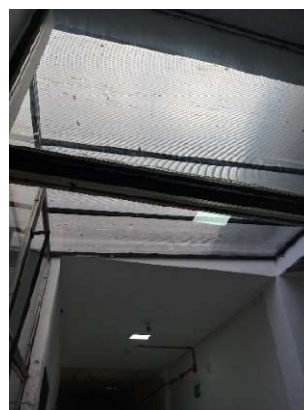
Foto 03: Remoção cobertura de policarbonato e estrutura metálica Poço de Luz
