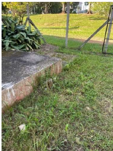
Foto 04: Demolição cisterna desativada
