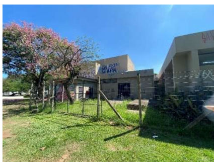
Foto 01: Alambrado a ser removido
