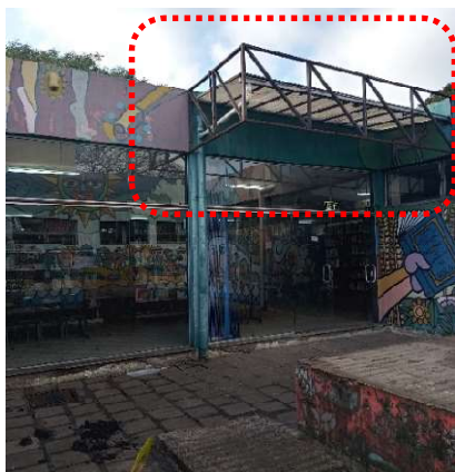
Foto 02: Remoção cobertura de policarbonato e estrutura metálica Pátio Interno
