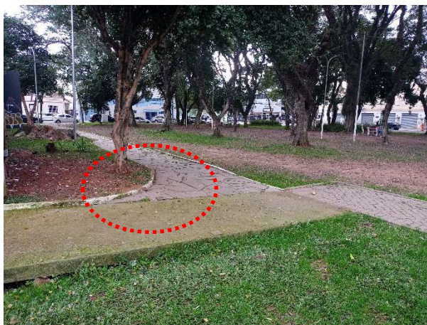
Foto 11: Local a ser removido o basalto irregular
