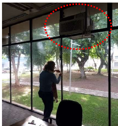
Foto 15: Remoção estrutura de ares-condicionados
