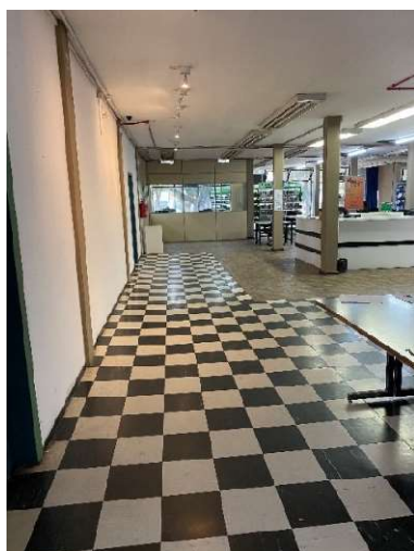
Foto 06: Remoção Piso Vinílico da Biblioteca
