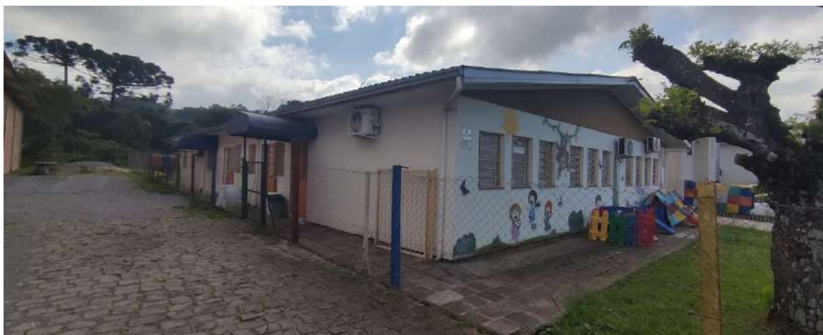
Figura 2 – Vista da fachada oeste do prédio existente
