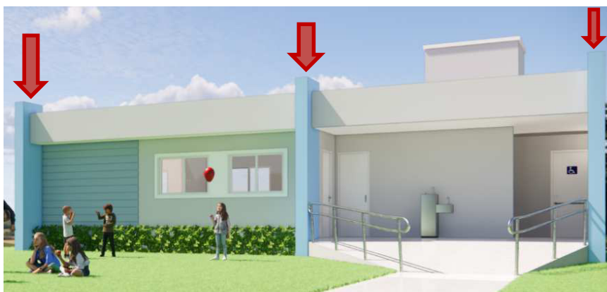
Imagem 26: localização dos pilares evidentes na fachada principal
