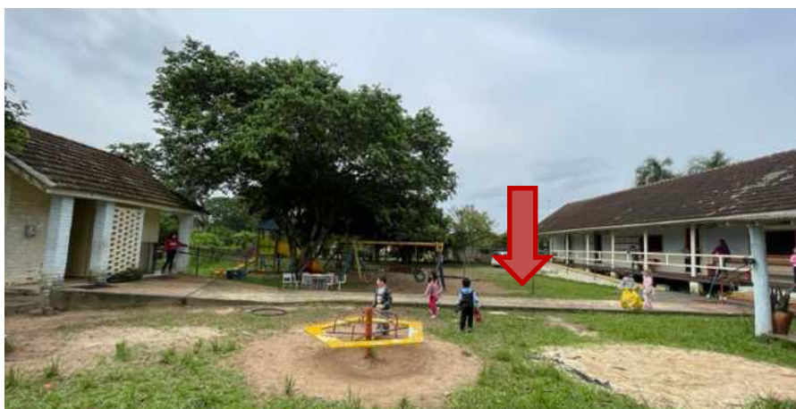
Imagem 18: Local da passarela que liga um bloco ao outro
