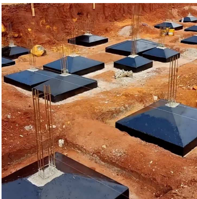
Imagem 08: Imagem ilustrativa da impermeabilização das sapatas
