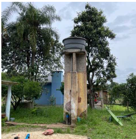
Imagem 05: Estrutura existente para a caixa d'água
