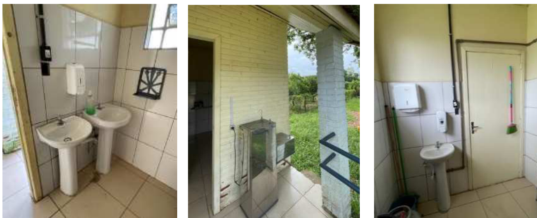
Imagens 19,20 e 21: Lavatório, acessórios e bebedouros que serão reaproveitados
