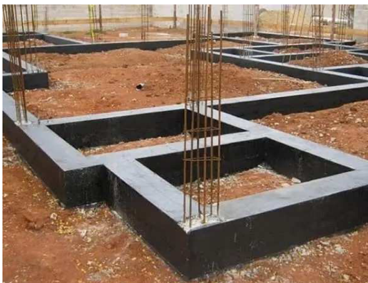
Imagem 07: Imagem ilustrativa da impermeabilização nas vigas de baldrame
