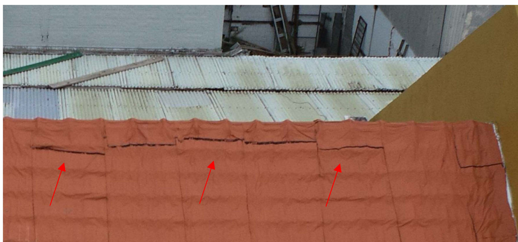
Imagem 13 – Rasgos na manta asfáltica
