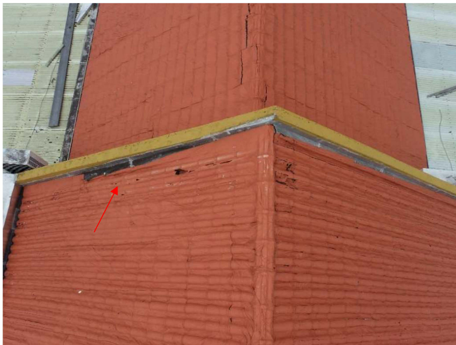
Imagem 14 – Manta asfáltica se descolando junto aos rufos e telha.
