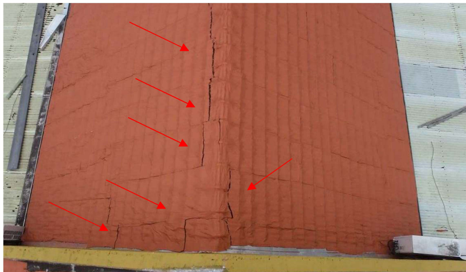
Imagem 12 – Presença de rasgos lineares na manta asfáltica
