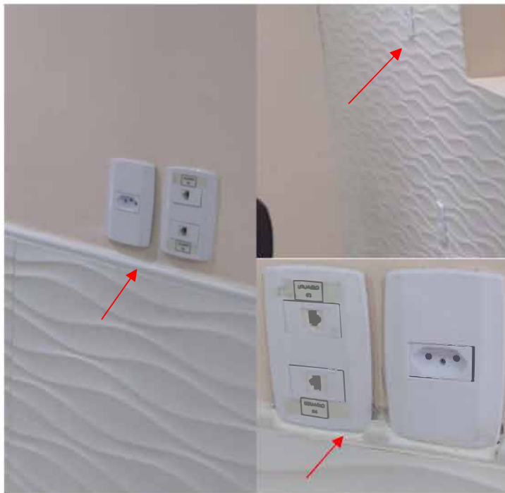
Imagem 4 – Tomadas médias desalinhadas horizontalmente.
