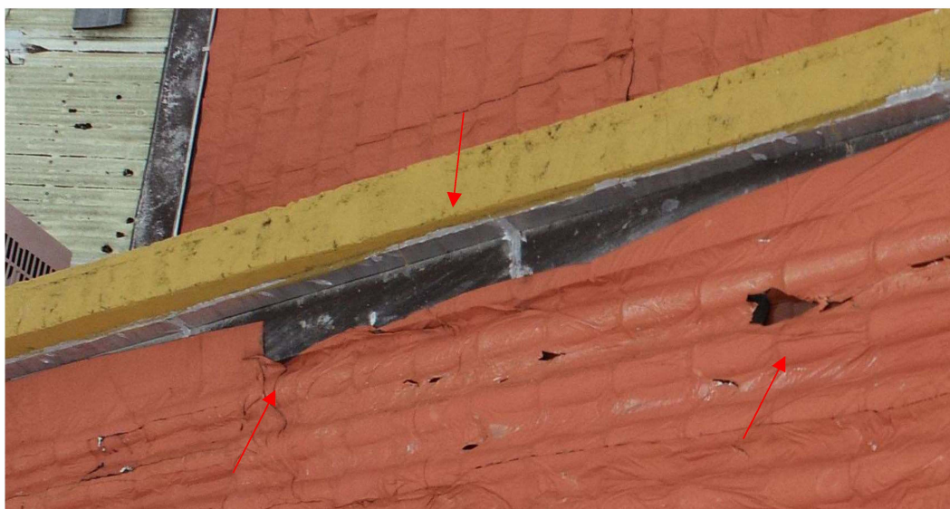
Imagem 15 – Manta asfáltica se descolando junto aos rufos e telha.
