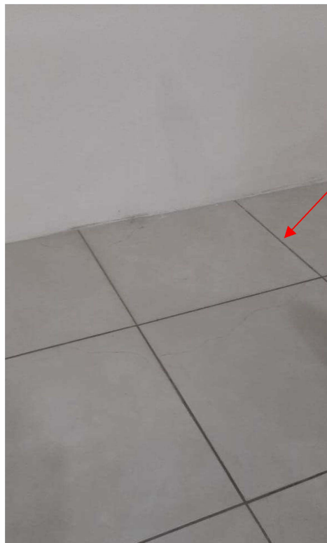
Imagem 20 – Água acumulada no piso oriunda da cobertura
