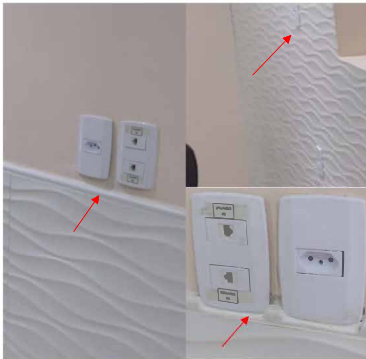
Imagem 4 – Tomadas médias desalinhadas horizontalmente.
