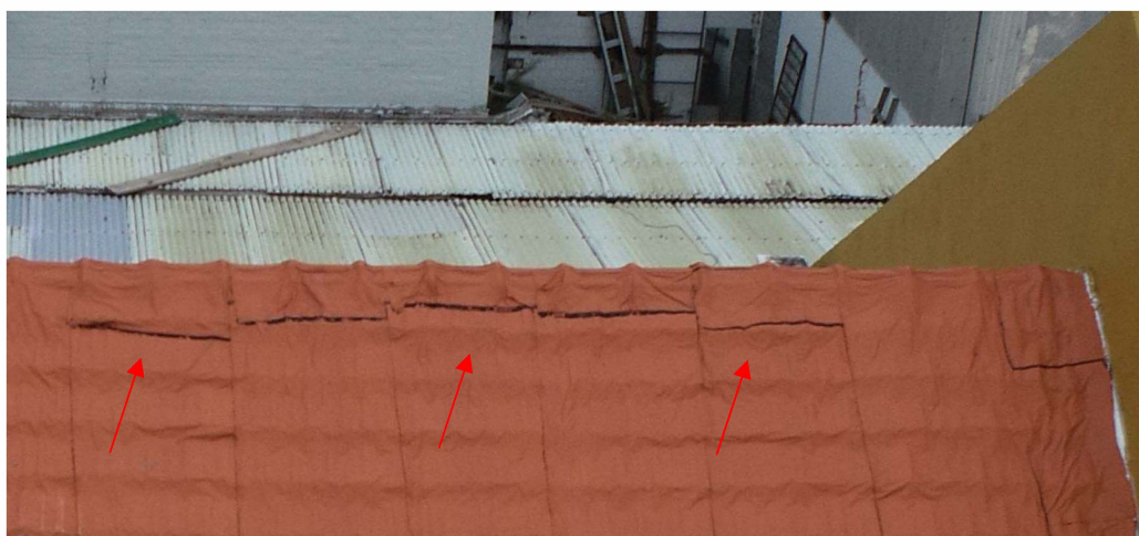
Imagem 13 – Rasgos na manta asfáltica
