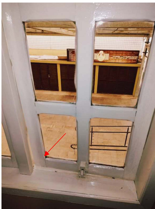
Imagem 3 – Janela da sala de arquivo sem encaixe adequado.
