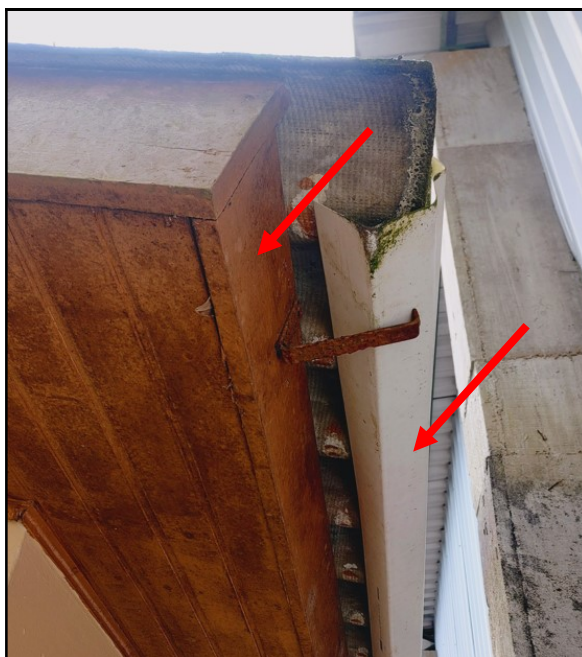
Imagem 6 – Espelho e calha de beiral a serem removidos.
