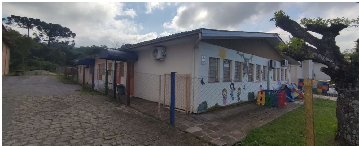
Figura 2 – Vista da fachada oeste do prédio existente
