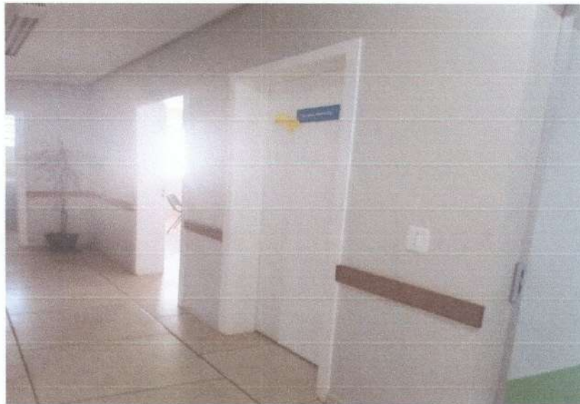
Figura 13: Entrada Almojarifado - Fechamento porta
