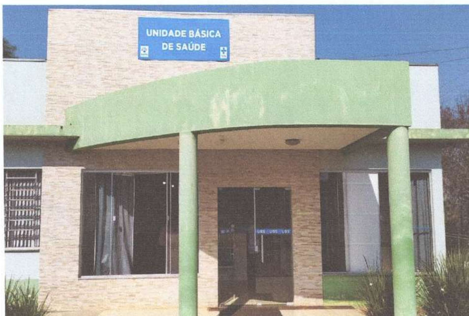
Figura 8: Revestimento em cerâmica a ser retirado
