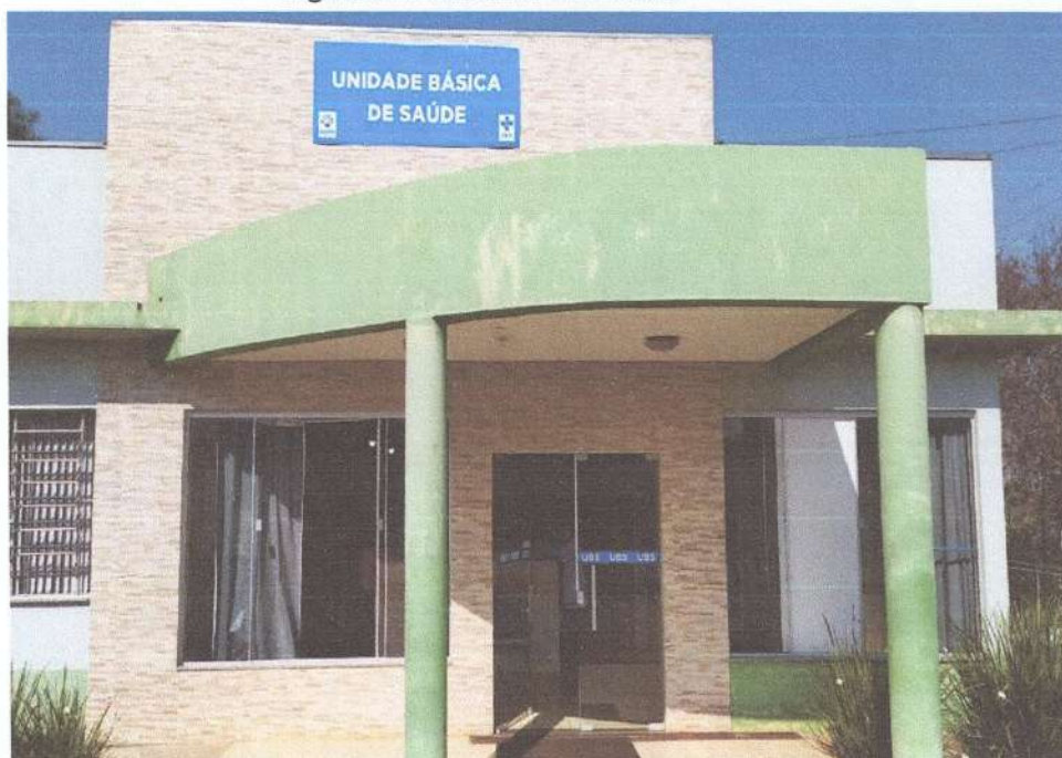
Figura 01: Posto a ser reformado.
