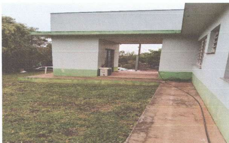
Figura 17: Local onde será feito ampliação do prédio
