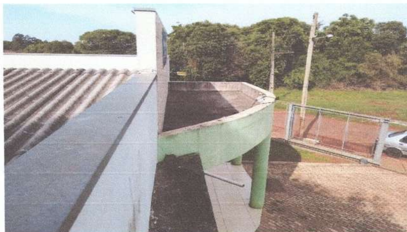
Figura 18: Cano a ser canalizado no pilar arquitetônico.
