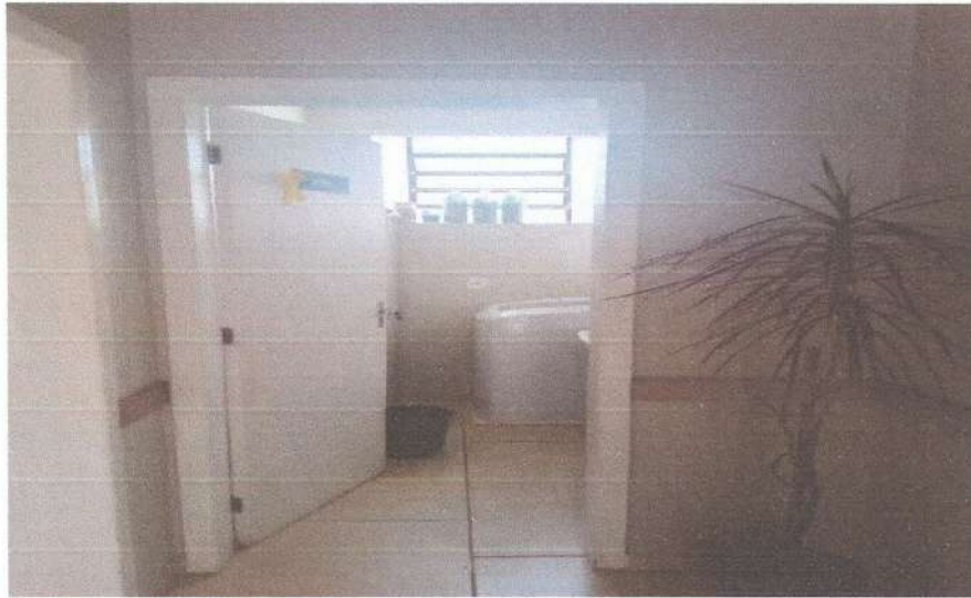
Figura 15: Lavabo a ser demolido para abertura da ampliação
