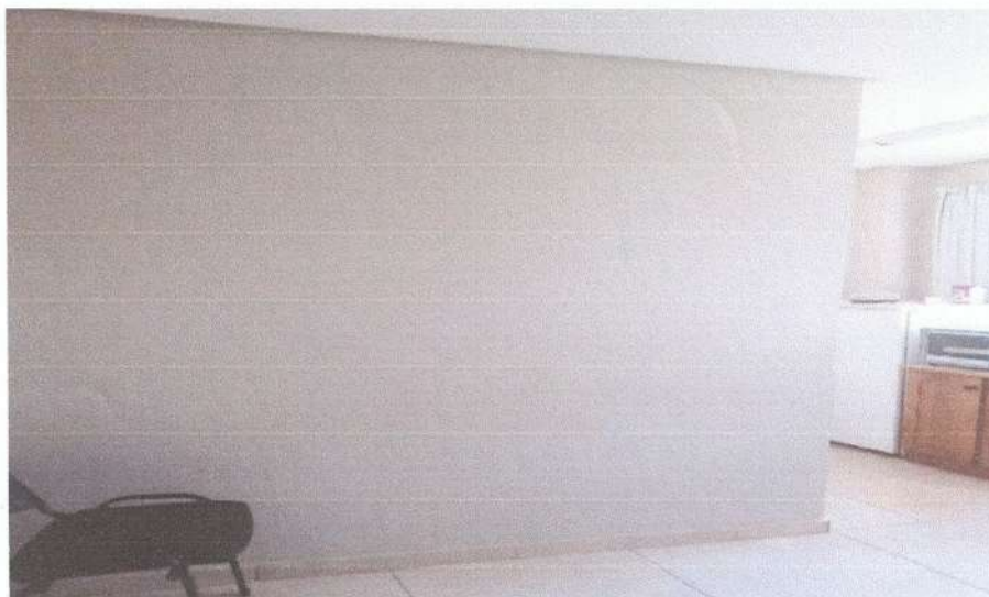
Figura 14: Paredes banheiro a ser removidas
